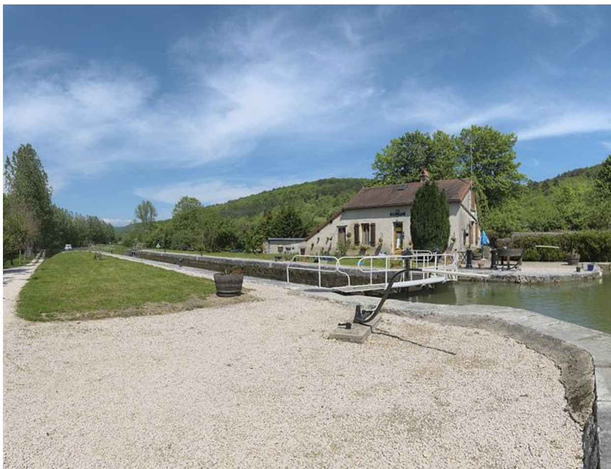
Vue d'ensemble de l'amont.
