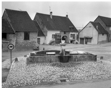
Vue de face. Phot. Jérôme Mongreville IVR43_19853900144X
