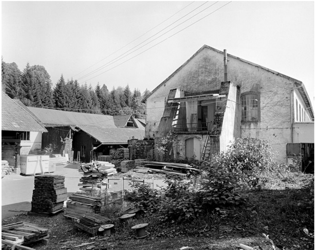
Pignon nord et contreforts de la salle de tissage. Les contreforts ont été placés contre ce pignon afin de réduire les oscillations provoquées par le fonctionnement des métiers à tisser.
