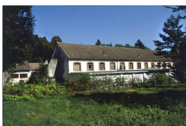
Façade occidentale de la salle de tissage.
