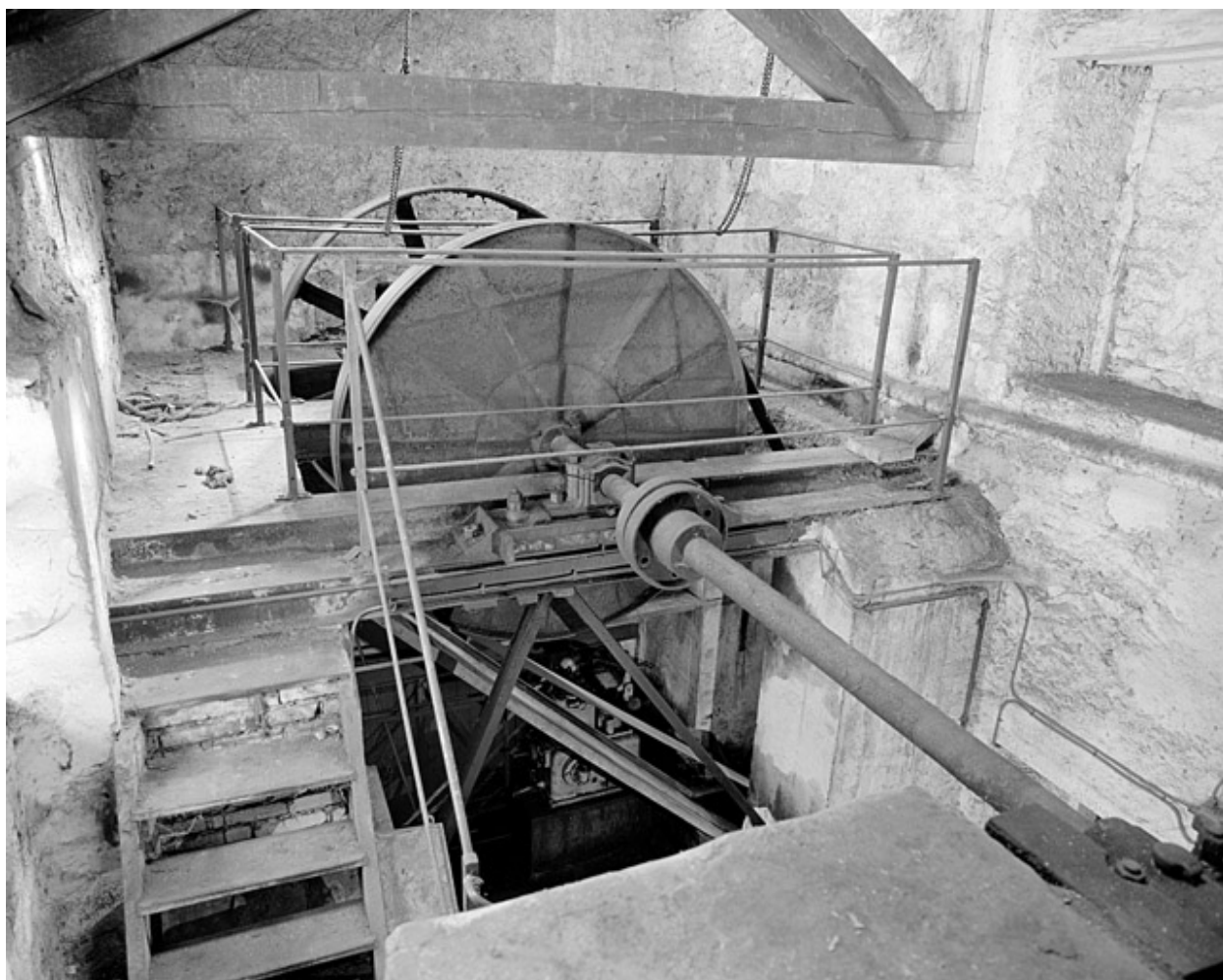
Système de transmissions de la turbine Kaplan.
