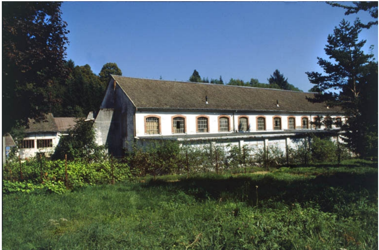
Façade occidentale de la salle de tissage.
