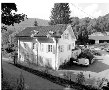
Le logement patronal. Phot. Yves Sancey IVR43_19999000199X
