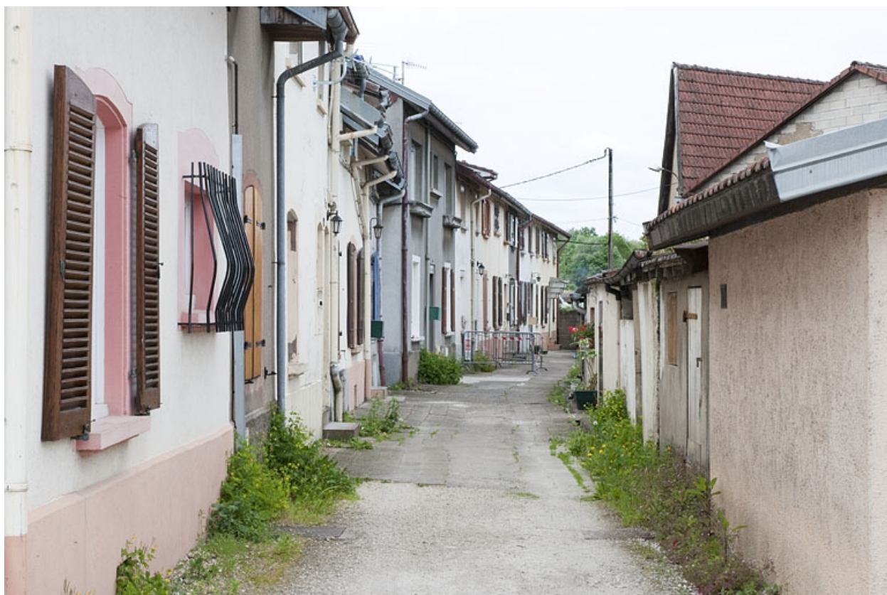
Façades ouest de la cite ouvrière.
