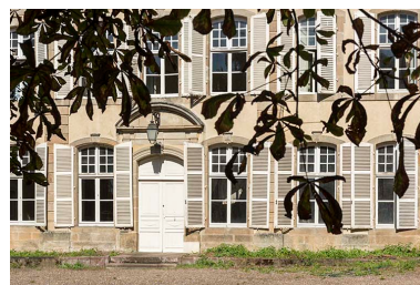
Façade antérieure : vue rapprochée. Phot. Sonia Dourlot IVR43_20167001157NUC4A
