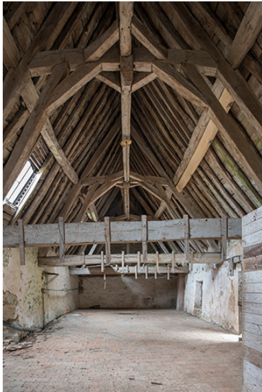
Dépendance : charpente. Phot. Sonia Dourlot IVR43_20167001169NUC4A
