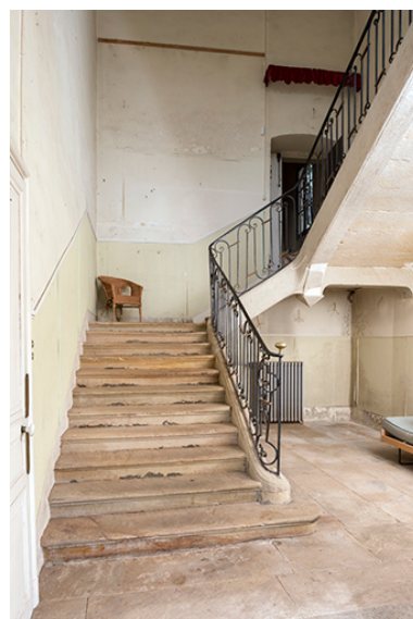
Vue de trois-quart de l'escalier principal. Phot. Sonia Dourlot IVR43_20167001161NUC4A
