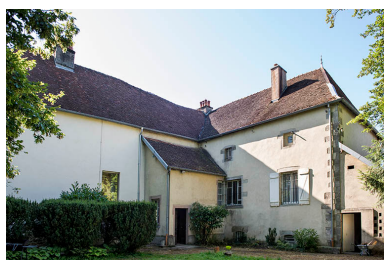
Les façades postérieures vues du nord. Phot. Sonia Dourlot IVR43_20167001153NUC4A
