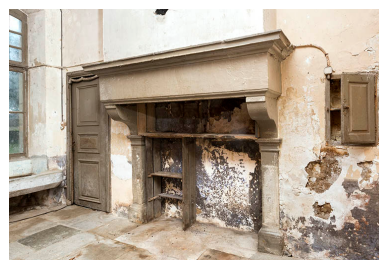
Cheminée au rez-de- chaussée. (Cuisine.) Phot. Sonia Dourlot IVR43_20167001176NUC4A
