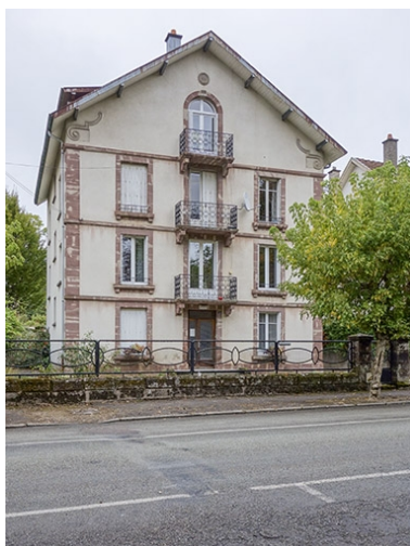
Vue depuis la rue. Phot. Fabien Dufoulon IVR43_20217000201NUC4A
