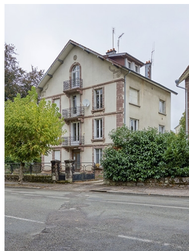
Vue depuis la rue. Phot. Fabien Dufoulon IVR43_20217000202NUC4A
