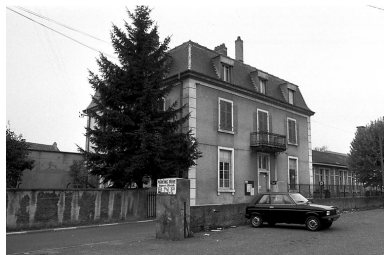
Vue d'ensemble. Phot. Bernard Lardière IVR43_19832500140Z
