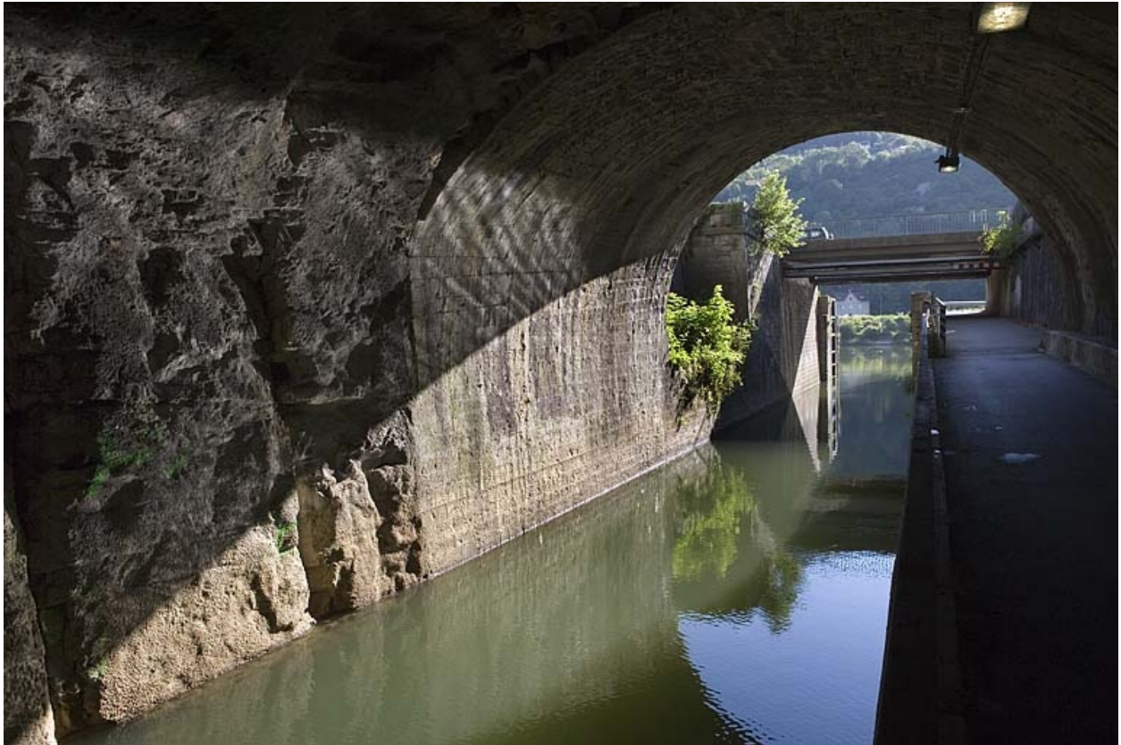
Vue d'ensemble depuis le tunnel.
