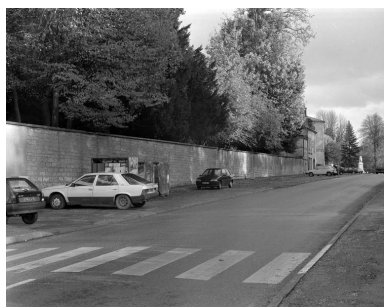
Restes de rempart le long de l'avenue Revon (vers l'ancien bastion de l'Arsenal). Phot. Yves Sancey IVR43_19947000096X
