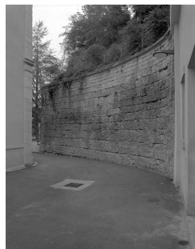
Restes du rempart du bastion du Boulevard dans la cour de l'hotel-dieu, à gauche de la façade antérieure de l'hotel-dieu. Phot. Yves Sancey IVR43_19947000092X
