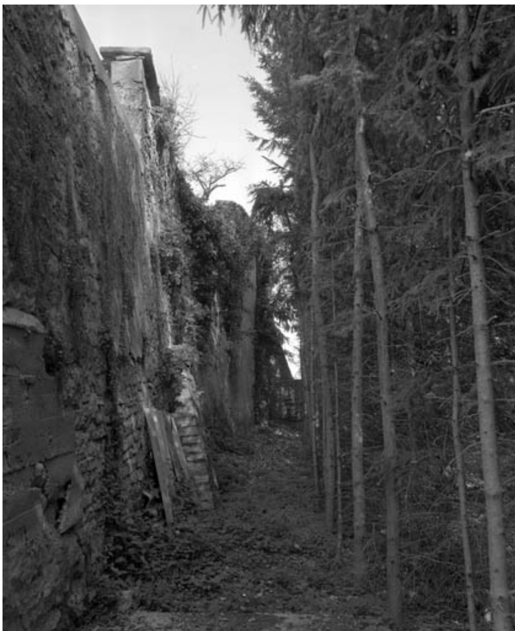
Restes de rempart du bastion de la Visitation (derrière la rue Cécile) : extrémité droite, de trois quarts gauche.
