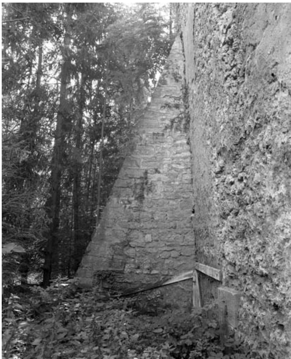
Restes de rempart du bastion de la Visitation (derrière la rue Cécile) : détail d'un contrefort.
