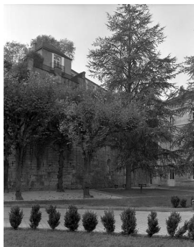
Restes du rempart du bastion du Boulevard dans la cour de l'hotel- dieu : de trois quarts gauche. Phot. Yves Sancey IVR43_19947000091X
