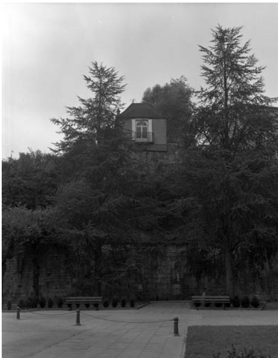
Restes du rempart du bastion du Boulevard dans la cour de l'hotel-dieu : de face.
