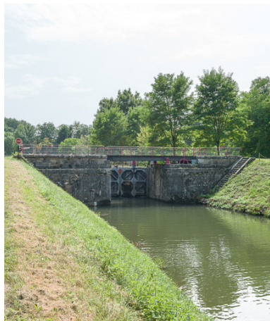
Vue du pont.
