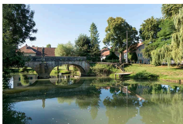
Vue du pont côté Nord Phot. Sonia Dourlot
