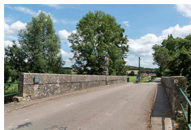
Le pont depuis Chemilly. Vue de l'ancien moulin en arrière-plan, aujourd'hui entreprise De Trevillers. Phot. Sonia Dourlot
