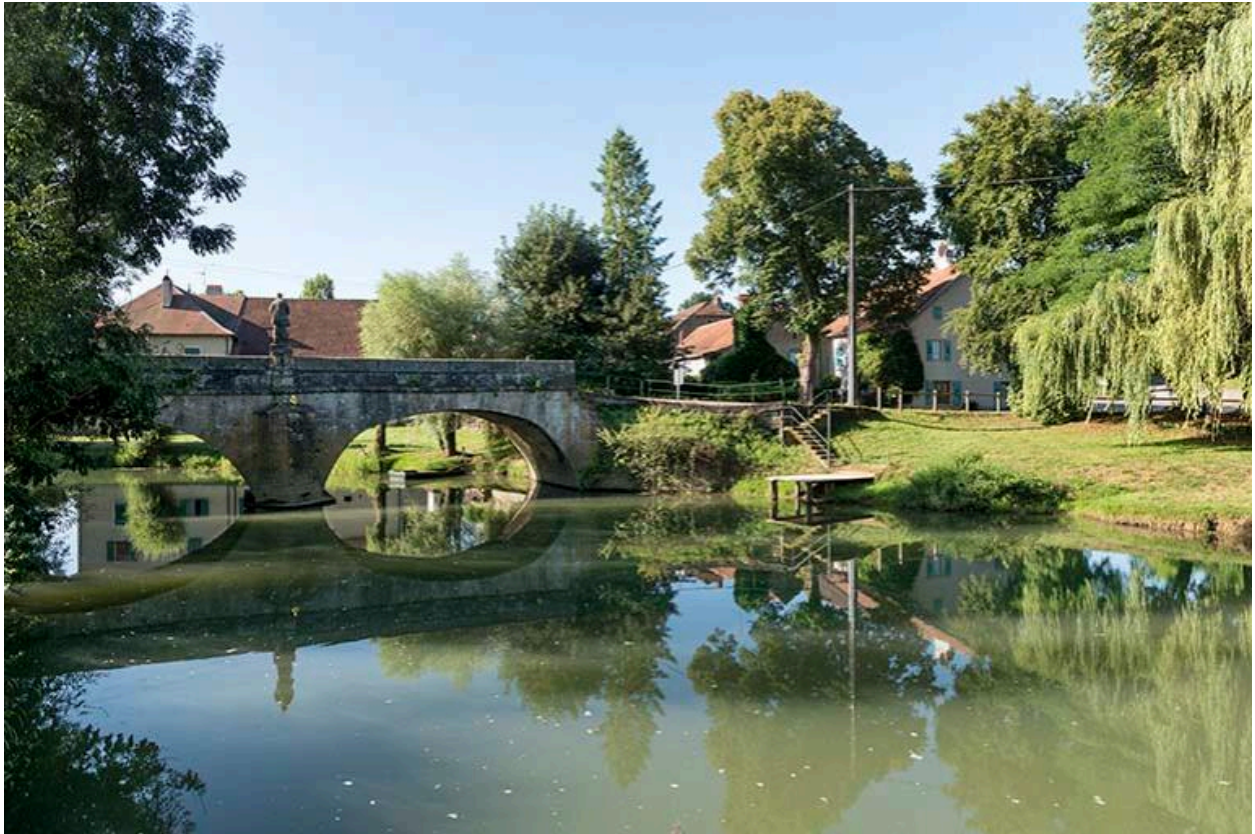
Vue du pont côté Nord
