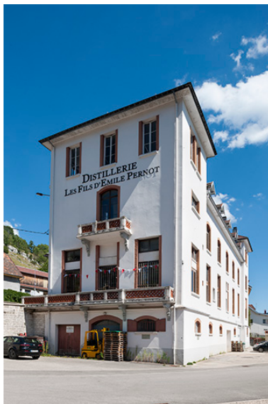
Pignon ouest et façade postérieure. Phot. Jérôme Mongreville IVR43_20162501172NUC4A
