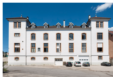
Façade postérieure. Phot. Jérôme Mongreville IVR43_20162501170NUC4A
