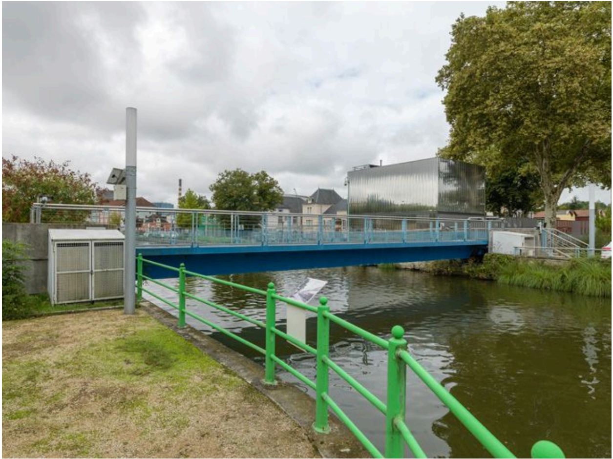
Vue d'ensemble de la passerelle à son niveau bas.
