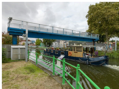
Passerelle remontée pour permettre le passage d'un bateau. Phot. Pierre-Marie Barbe-Richaud IVR26_20177100489NUC4A
