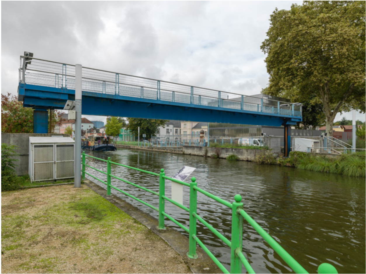
Passerelle remontée après le passage d'un bateau.
