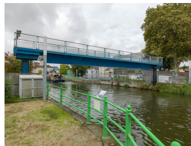
Passerelle remontée après le passage d'un bateau. Phot. Pierre-Marie Barbe-Richaud IVR26_20177100490NUC4A
