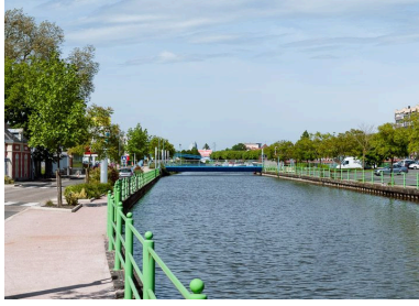
Vue d'ensemble avec le port de Montceau-les-Mines en arrière-plan. Phot. Pierre-Marie Barbe-Richaud IVR26_20137100426NUC4AQ
