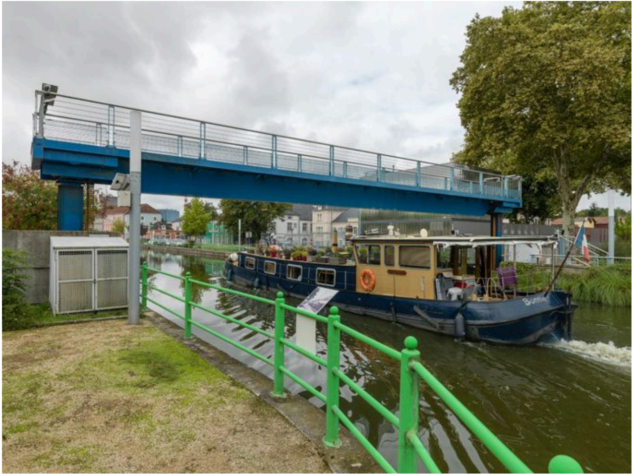
Passerelle remontée pour permettre le passage d'un bateau.
