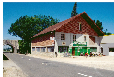
Entrepôt industriel. Phot. Jérôme Mongreville IVR43_19963900441ZA
