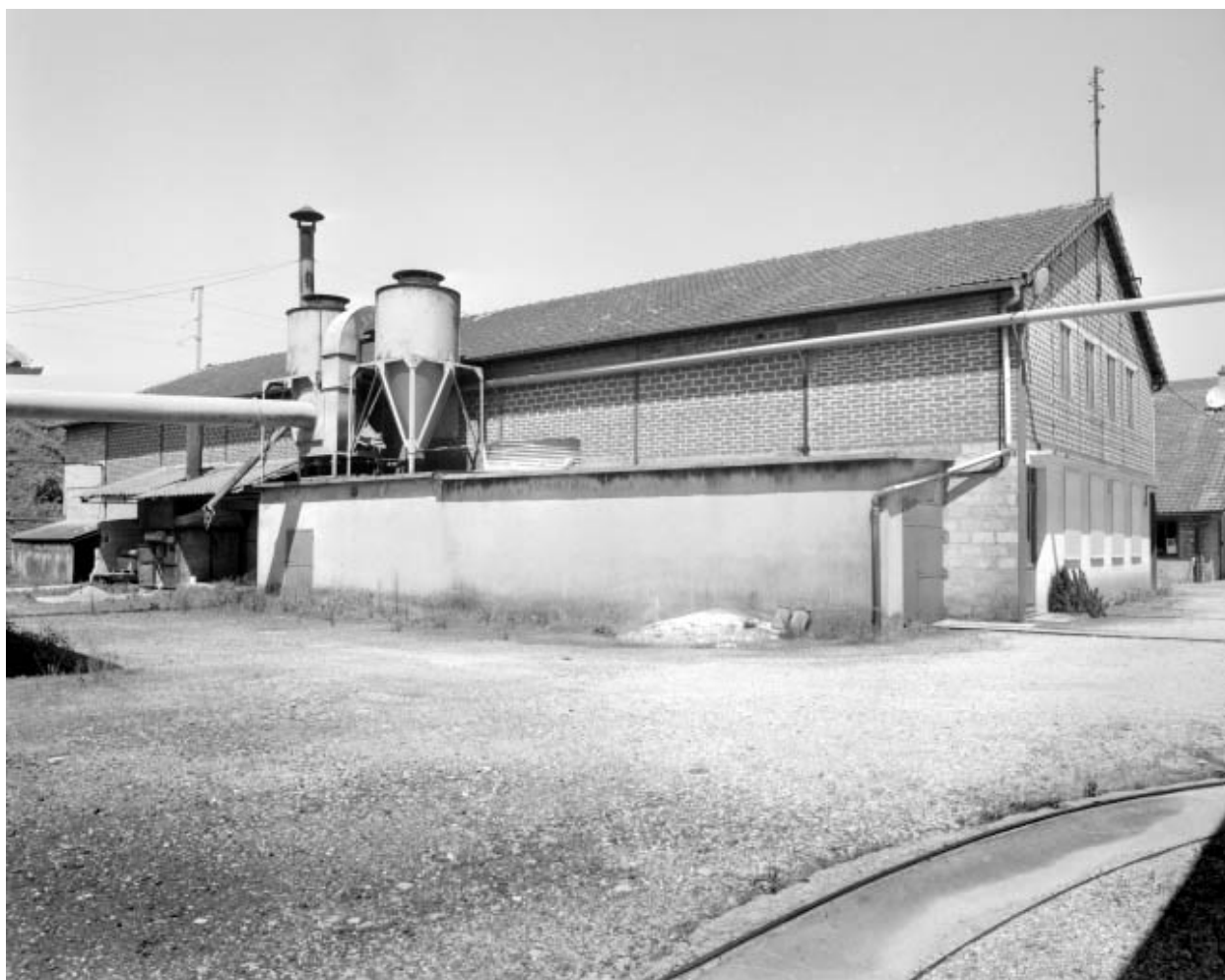
Atelier de fabrication, atelier de conditionnement, bureau.
