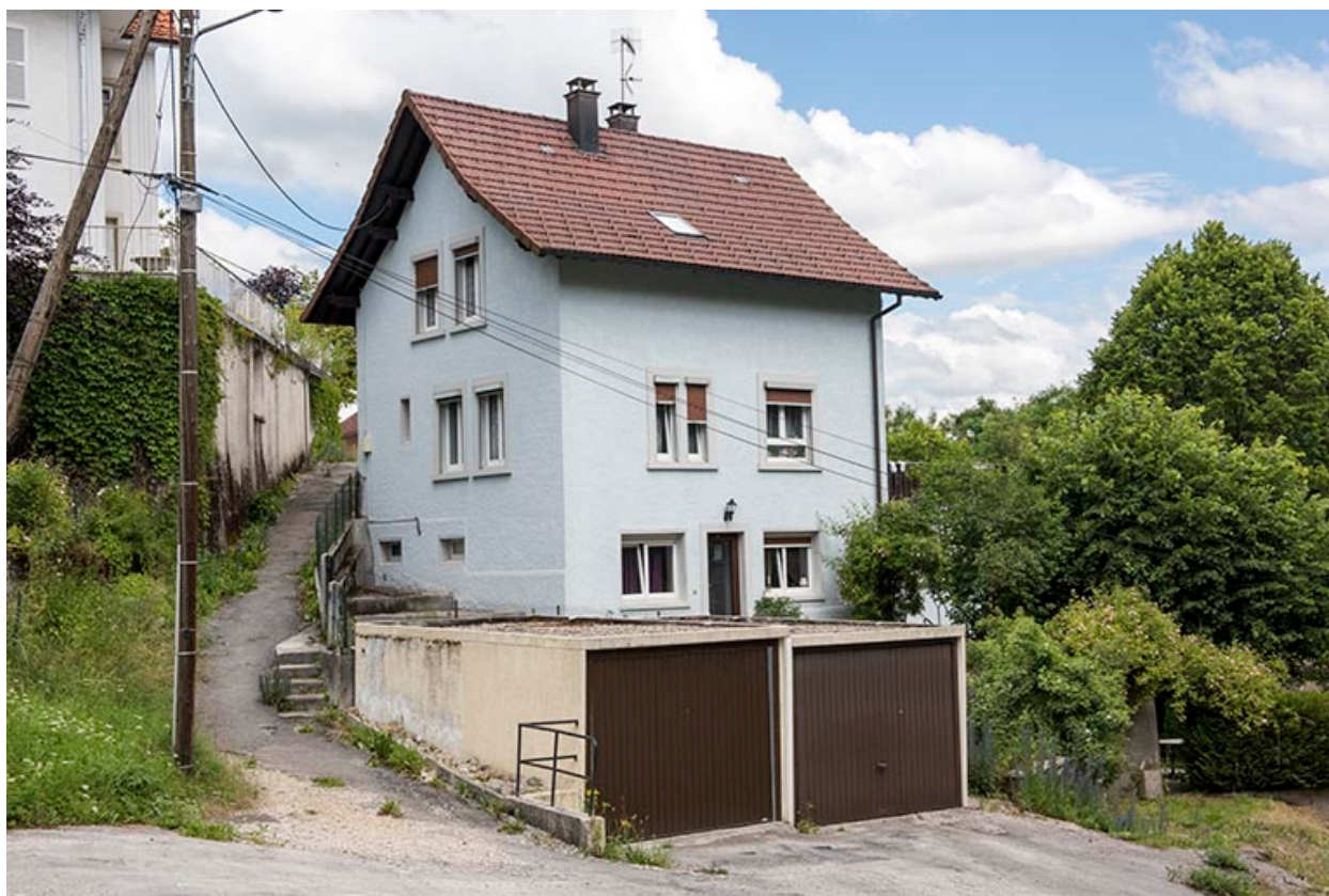
Maison : façades postérieure et latérale droite.
