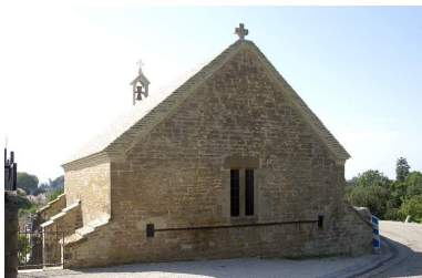
Façade postérieure. Phot. Michel Thierry IVR26_20047101175NUC2A
