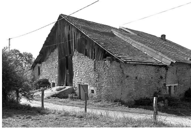
Vue générale depuis la rue. Phot. Yves Sancey IVR43_19802500909X
