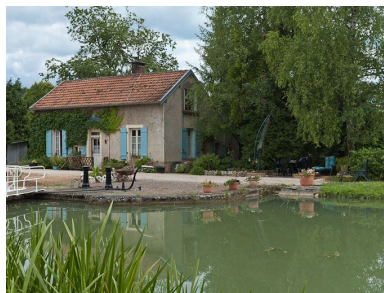
Vue amont du site d'écluse. Phot. Pierre-Marie Barbe-Richaud IVR26_20112103496NUC2AQ
