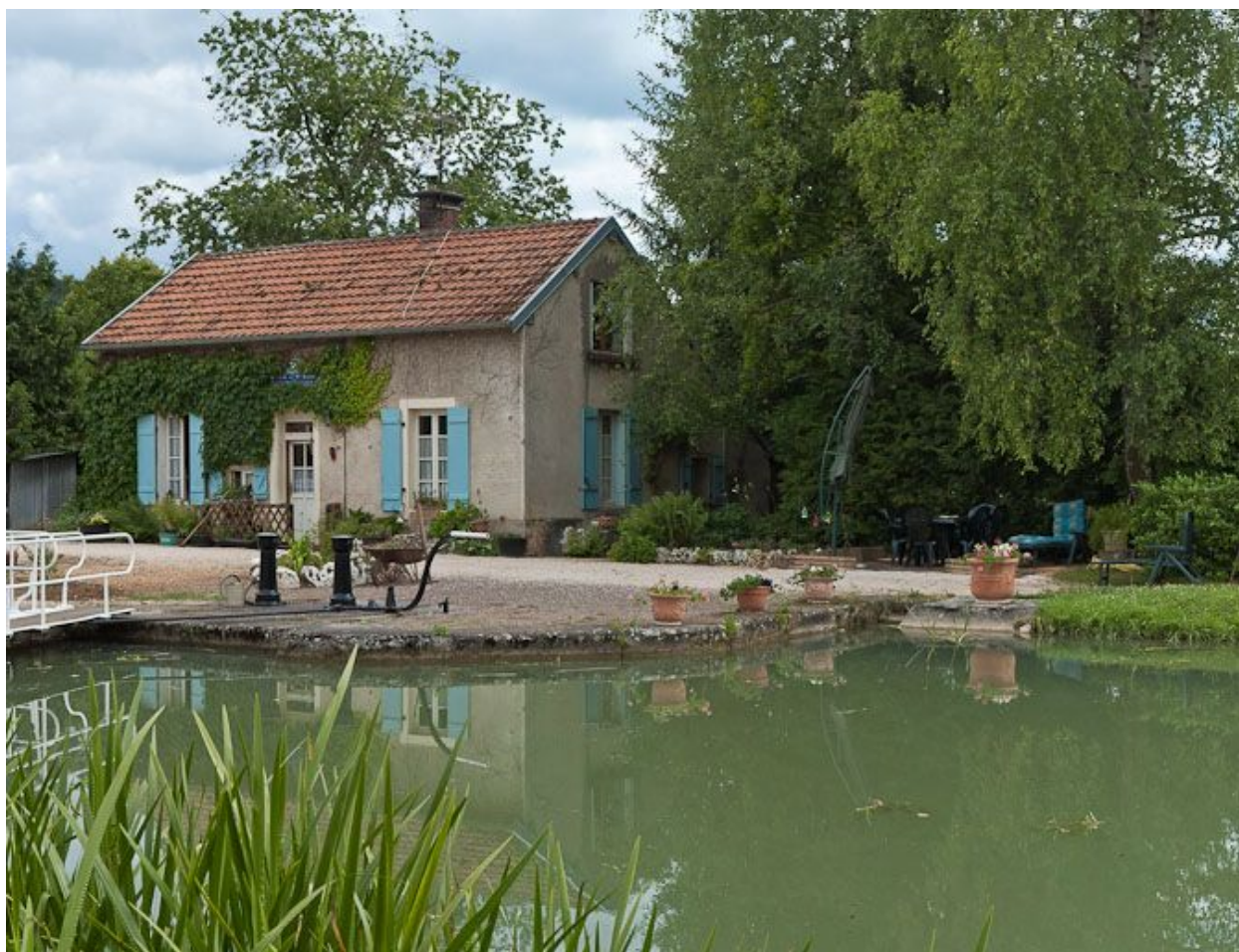
Vue amont du site d'écluse.
