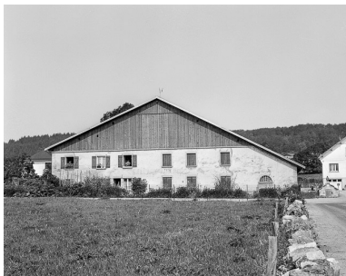
Ferme située rue de l'Ecole : façade antérieure. Phot. Dominique Dominguez IVR43_19792500868X
