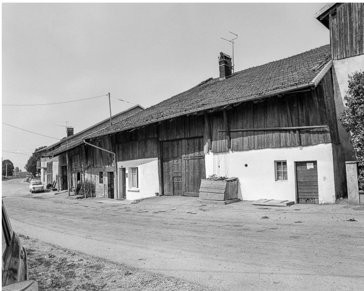
Ferme située rue de l'Ecole : façade antérieure.
