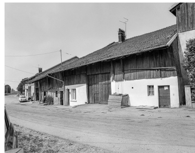
Ferme située rue de l'Ecole : façade antérieure. Phot. Dominique Dominguez IVR43_19792500873X
