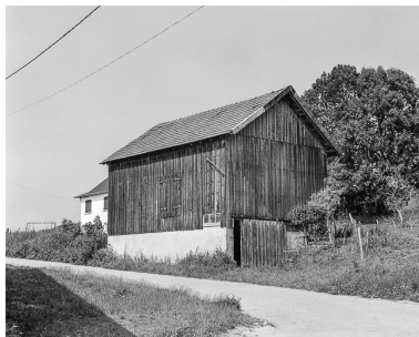
Remise cadastrée 1933 B1 94 : vue d'ensemble. Phot. Dominique Dominguez IVR43_19792500871X
