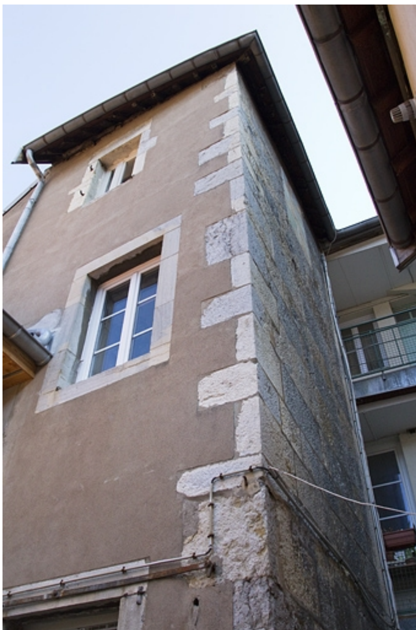
Logis principal : détail de l'aile sur cour.
