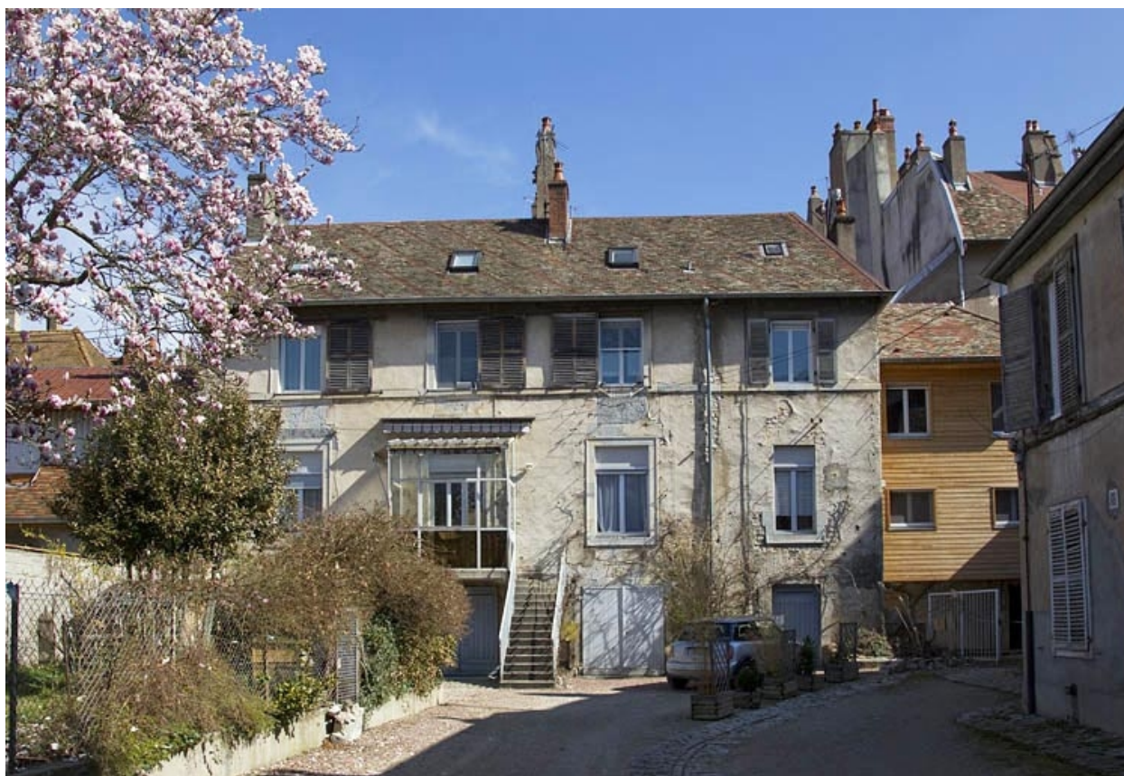
Vue du premier logis secondaire, de face.
