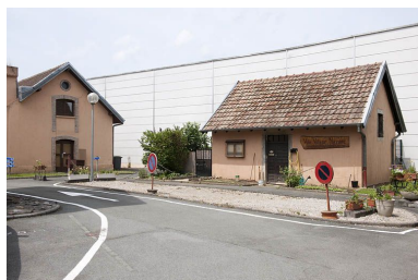
Bâtiments nord. Phot. Jérôme Mongreville IVR43_20112501611NUC4A
