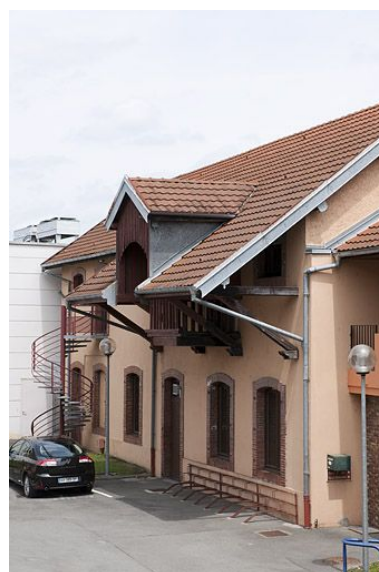
Façade des magasins de stockage. Phot. Jérôme Mongreville IVR43_20112501610NUC4A
