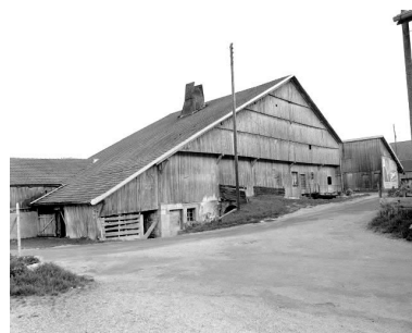
Façade antérieure. Phot. Dominique Humbert IVR43_19762500606X
