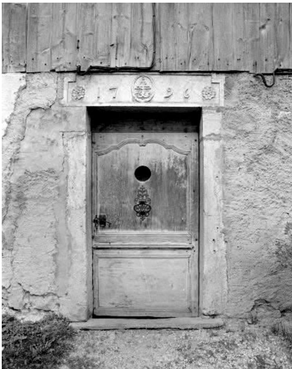
Façade antérieure : porte d'entrée.
