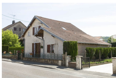
Maison individuelle. Phot. Jérôme Mongreville IVR43_20097000314NUC2A
