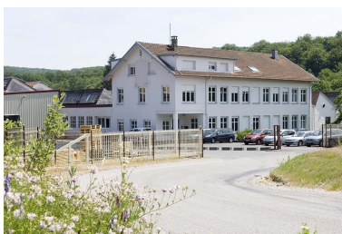
Le bâtiment des bureaux. Phot. Jérôme Mongreville IVR43_20097000318NUC2A
