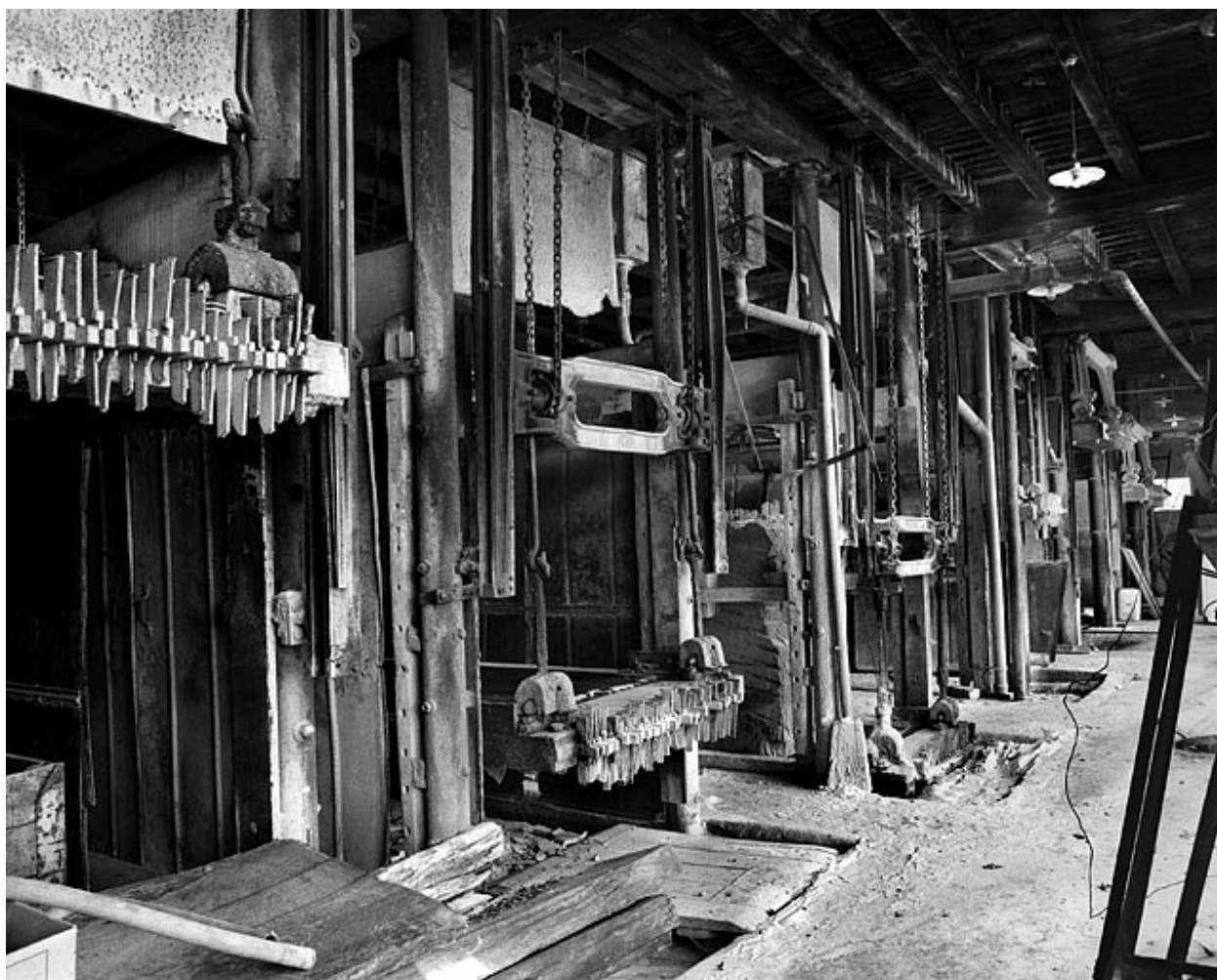
Vue d'ensemble des châssis multilames.
