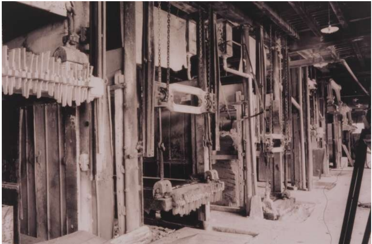
Vue d'ensemble des châssis multilames.
