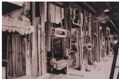
Vue d'ensemble des châssis multilames. Phot. Yves Sancey IVR43_19933900024ZA
