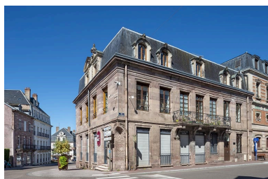
Maison Desgranges, façade sud et façade est. Phot. Jérôme Mongreville IVR43_20207000525NUC4A
