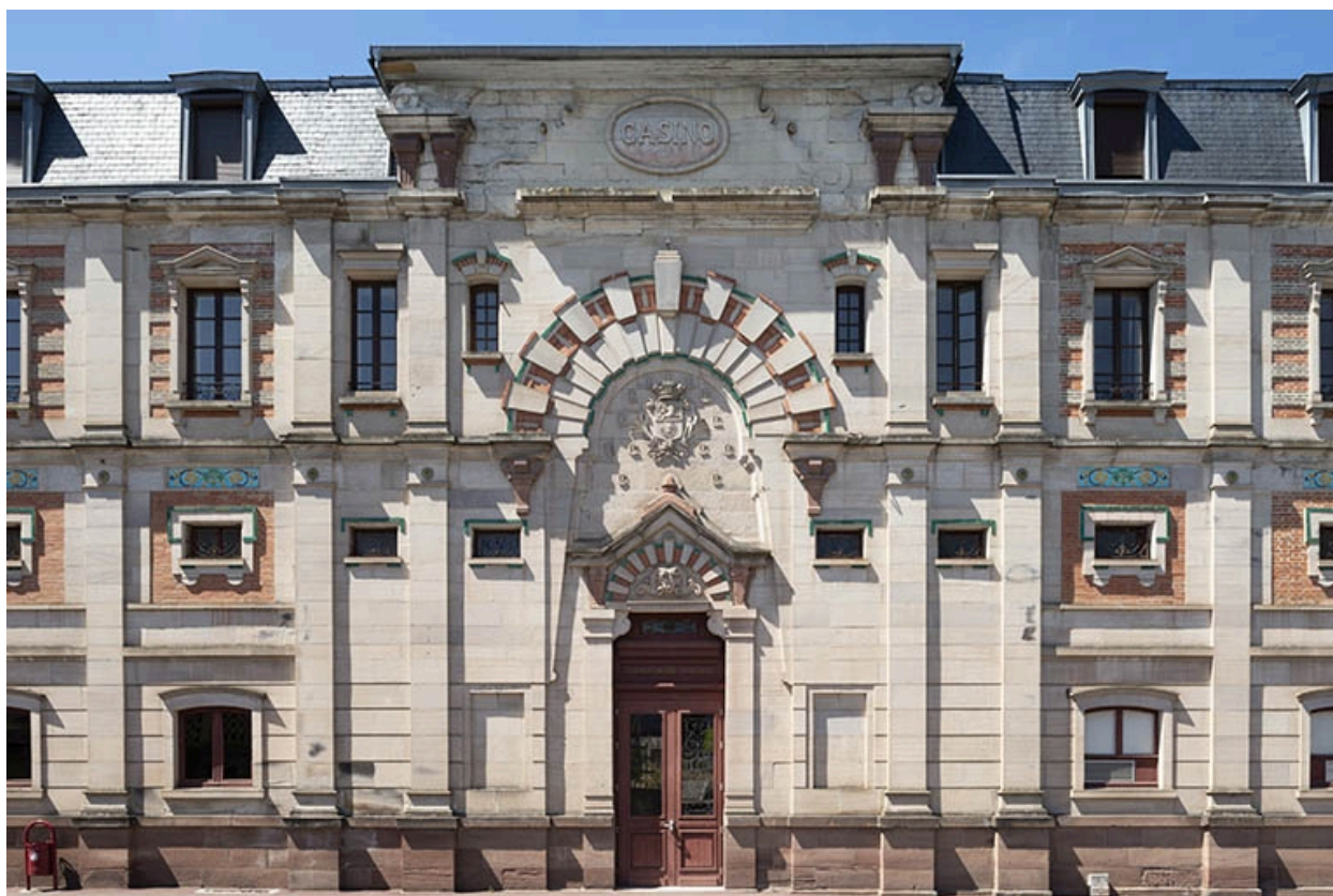
Façade sur la rue de Grammont, partie centrale.
