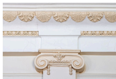
Salle : chapiteau surmontant un pilastre. Phot. Jérôme Mongreville IVR43_20207000610NUC4A
