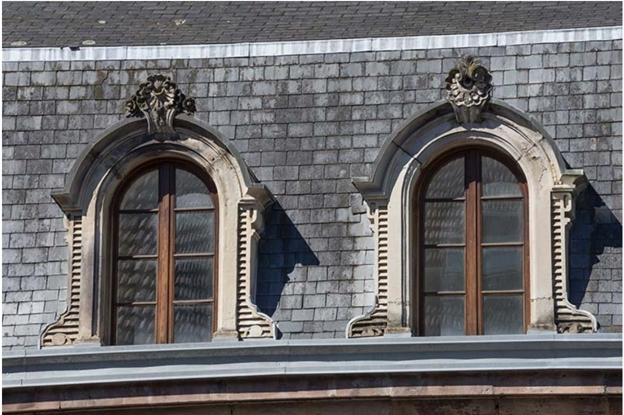
Maison Desgranges, lucarnes est (lucarnes latérales).
