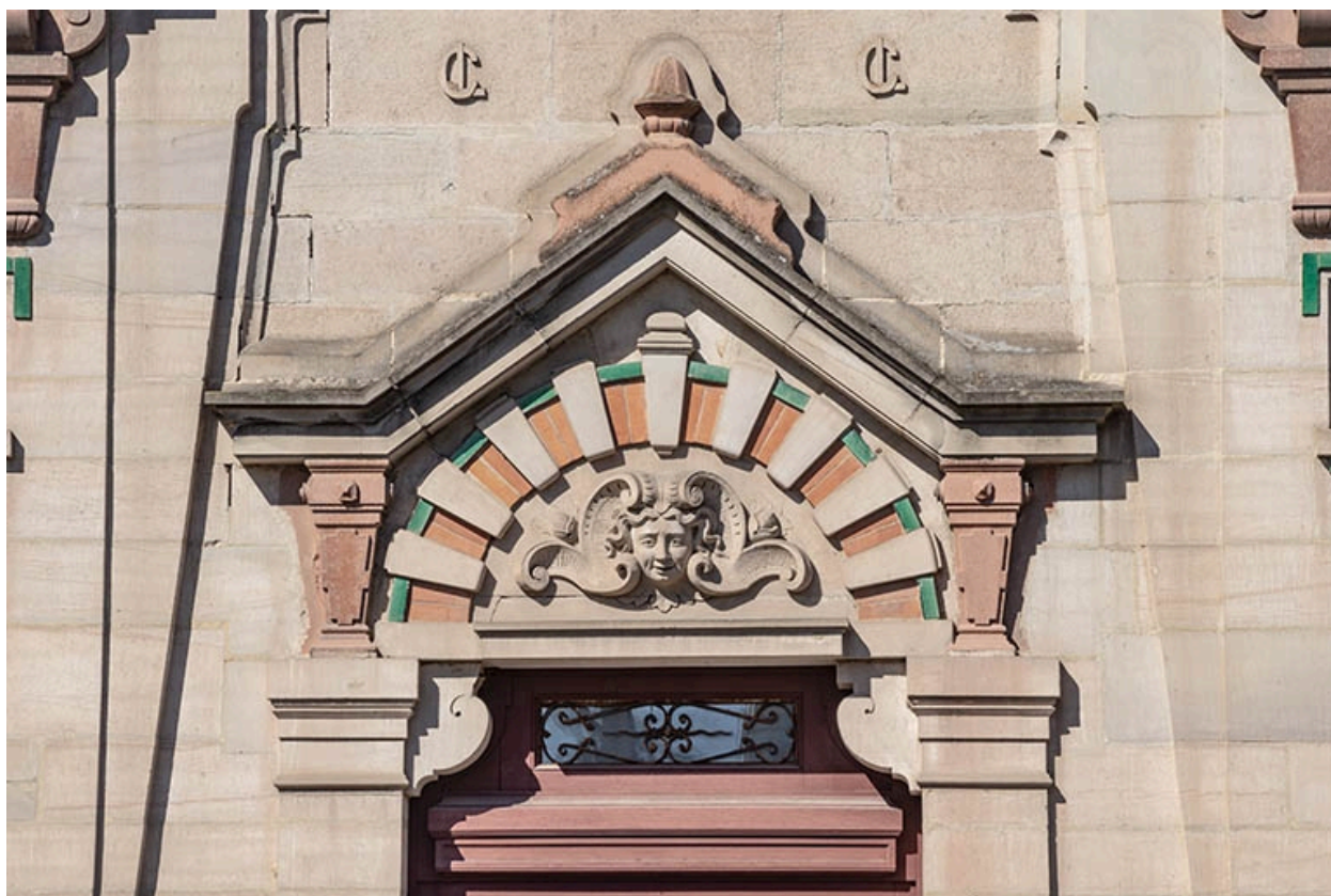
Façade sur la rue de Grammont, partie centrale, portail, détail : tympan.
