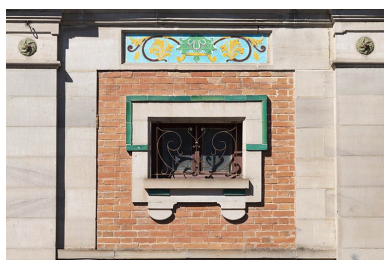
Façade sur la rue de Grammont, baies du deuxième niveau. Phot. Jérôme Mongreville IVR43_20207000551NUC4A
