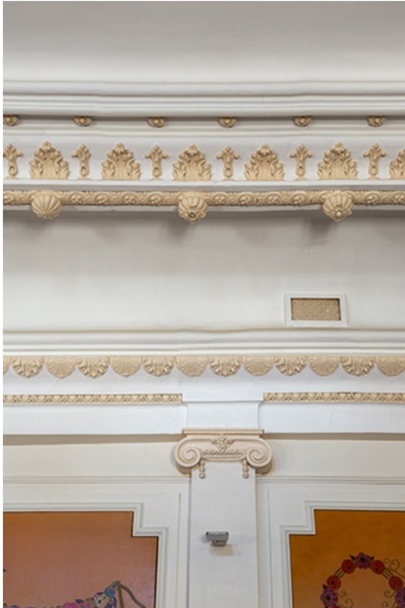
Salle : voissure (vue de face).
