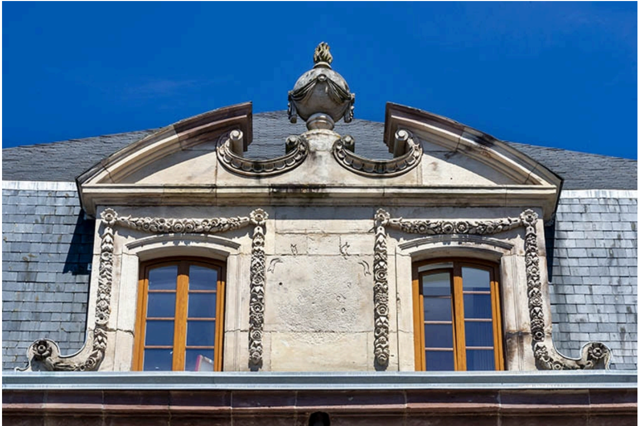
Maison Desgranges, lucarne sud.
