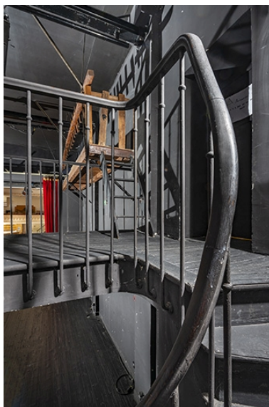
Scène, détail : escalier d'accès au pont. Phot. Jérôme Mongreville IVR43_20207000616NUC4A
