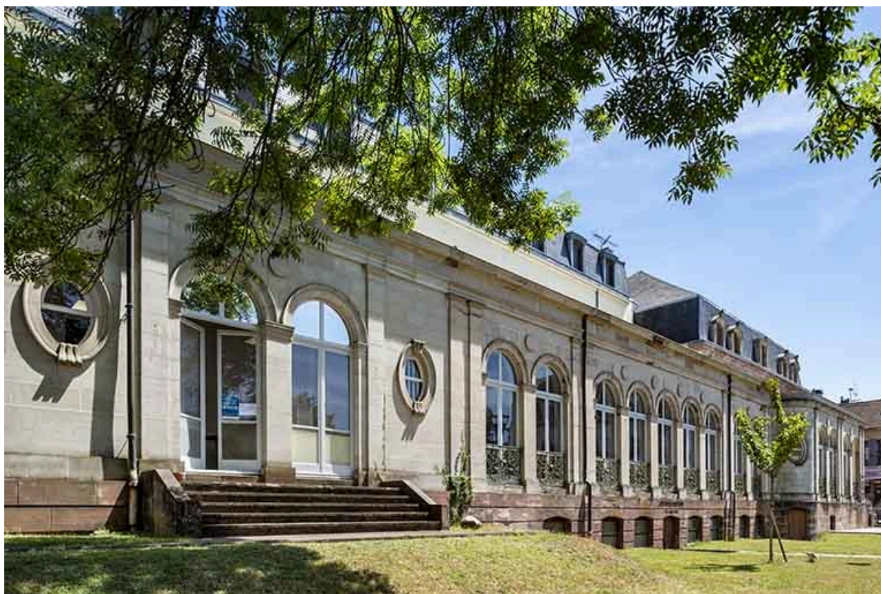
Galerie en façade ouest, vue depuis le nord-ouest (vue rapprochée).
