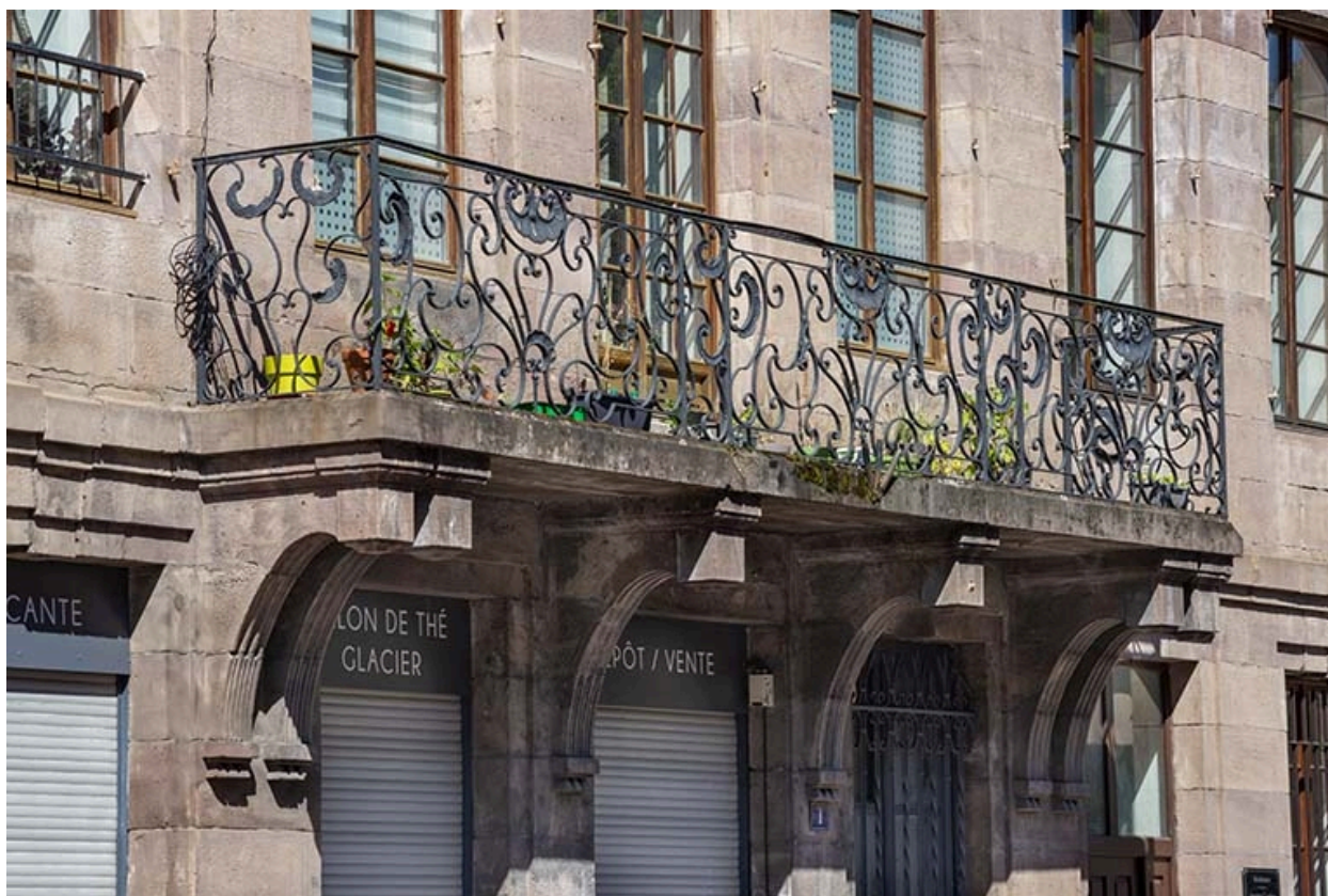
Maison Desgranges, façade est, balcon.
