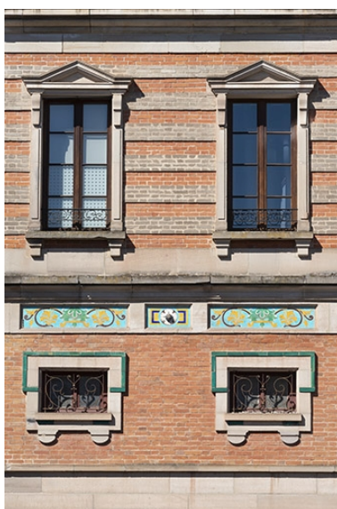
Façade sur la rue de Grammont, baies du deuxième et du troisième niveau. Phot. Jérôme Mongreville IVR43_20207000552NUC4A
