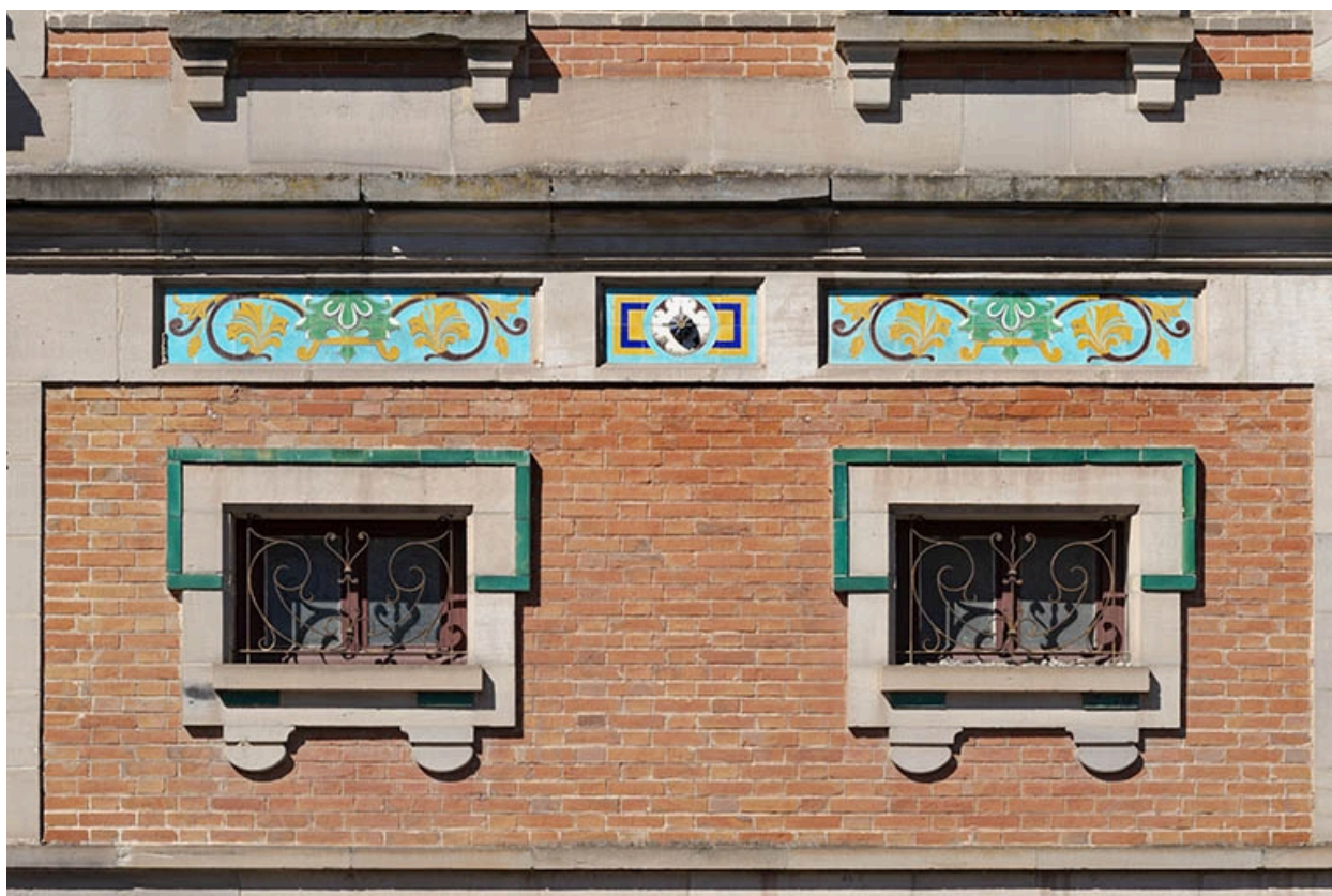
Façade sur la rue de Grammont, baies du deuxième niveau.
