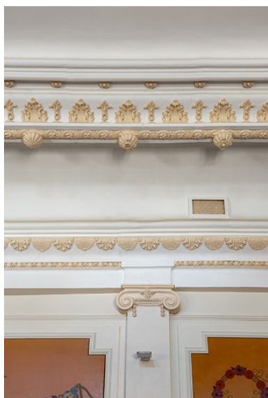
Salle : voussure (vue de face). Phot. Jérôme Mongreville IVR43_20207000612NUC4A
