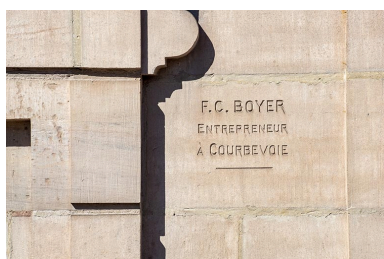
Façade sur la rue de Grammont, partie centrale, inscription : "F.C. BOYER / ENTREPRENEUR / À COURBEVOIE". Phot. Jérôme Mongreville IVR43_20207000539NUC4A
