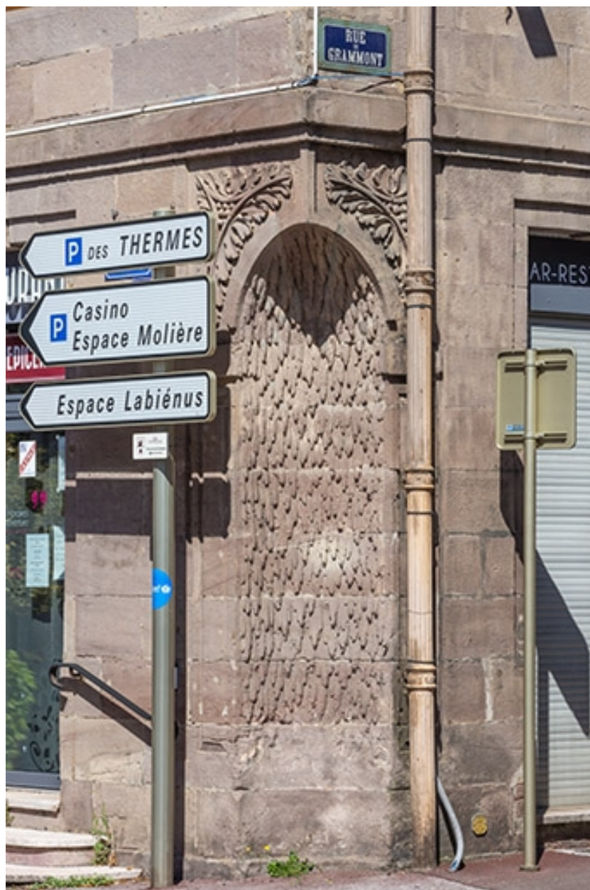
Maison Desgranges, niche dans l'angle.
