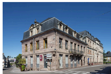
Maison Desgranges, façade sud et façade est. Phot. Jérôme Mongreville IVR43_20207000526NUC4A
