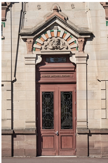
Façade sur la rue de Grammont, partie centrale, portail, détail. Phot. Jérôme Mongreville IVR43_20207000545NUC4A
