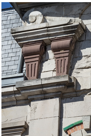
Façade sur la rue de Grammont, partie centrale, portail, détail : pilastres en gaine jumelés surmontés d'une volute. Phot. Jérôme Mongreville IVR43_20207000542NUC4A
