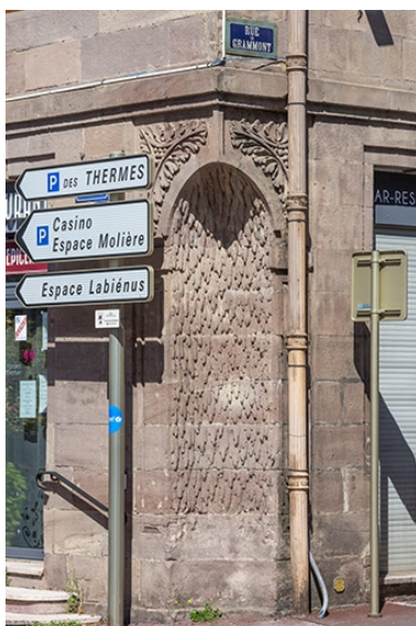
Maison Desgranges, niche dans l'angle. Phot. Jérôme Mongreville IVR43_20207000528NUC4A
