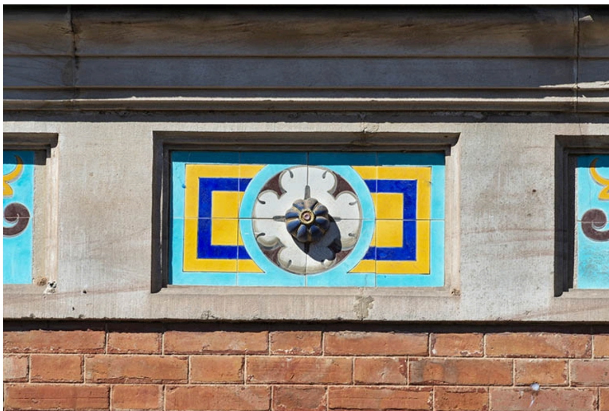
Façade sur la rue de Grammont, frise ornementale séparant le deuxième et le troisième niveau, détail.
