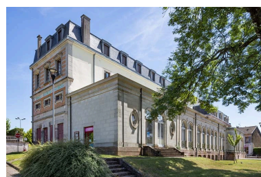
Galerie en façade ouest, vue depuis le nord-ouest. Phot. Jérôme Mongreville IVR43_20207000537NUC4A
