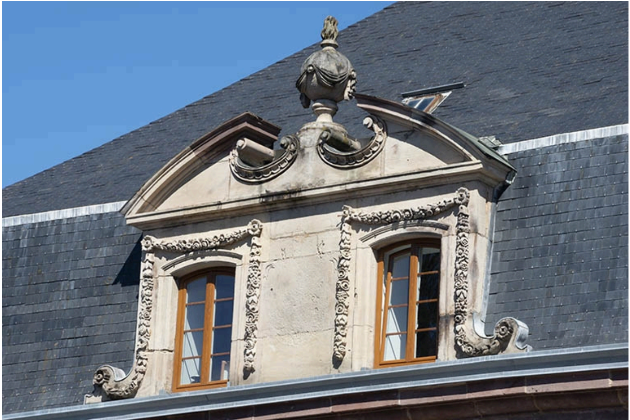
Maison Desgranges, lucarne sud.
