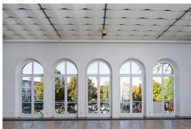
Galerie, vue en direction de l'ouest. Phot. Jérôme Mongreville IVR43_20207000595NUC4A
