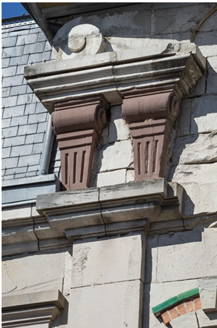
Façade sur la rue de Grammont, partie centrale, portail, détail : pilastres en gaine jumelés surmontés d'une volute.
