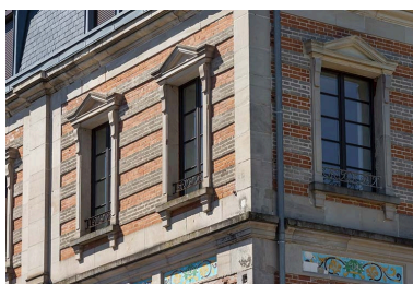
Façade sur la rue de Grammont, baies du troisième niveau. Phot. Jérôme Mongreville IVR43_20207000553NUC4A
