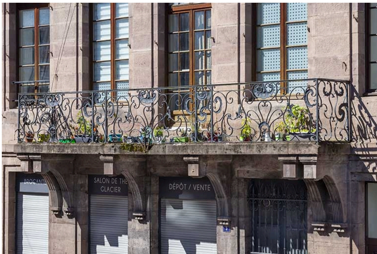
Maison Desgranges, façade est, balcon.
