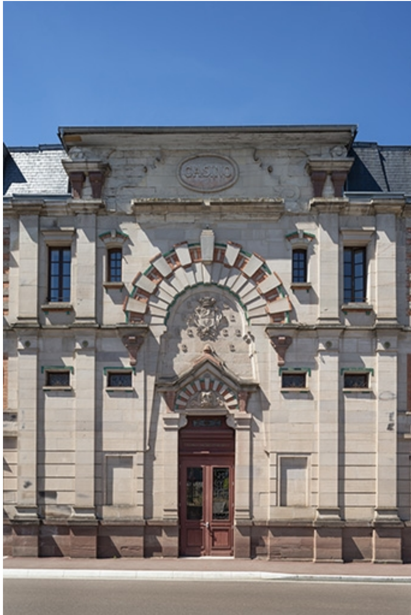
Façade sur la rue de Grammont, partie centrale.
