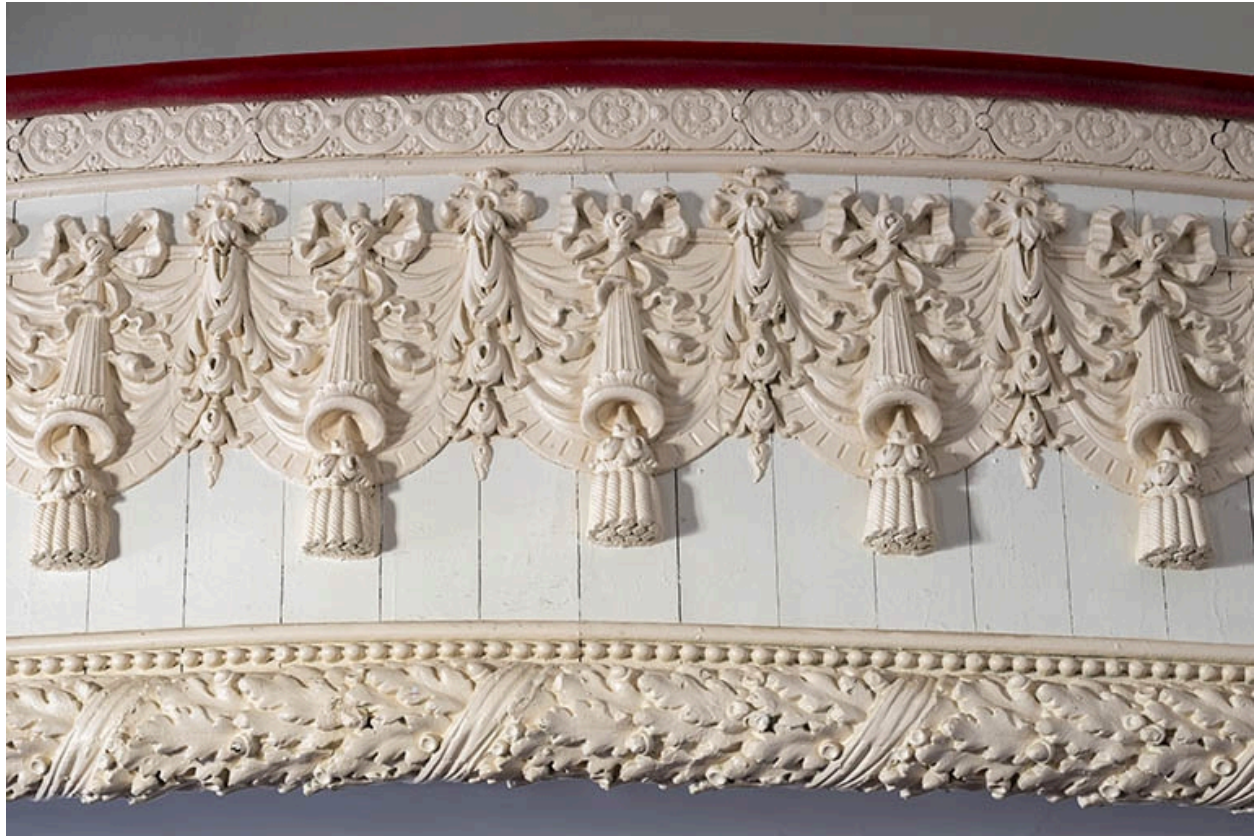
Salle : balcon (détail).
