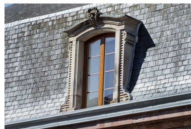
Maison Desgranges, lucarne est (lucarne centrale). Phot. Jérôme Mongreville IVR43_20207000523NUC4A
