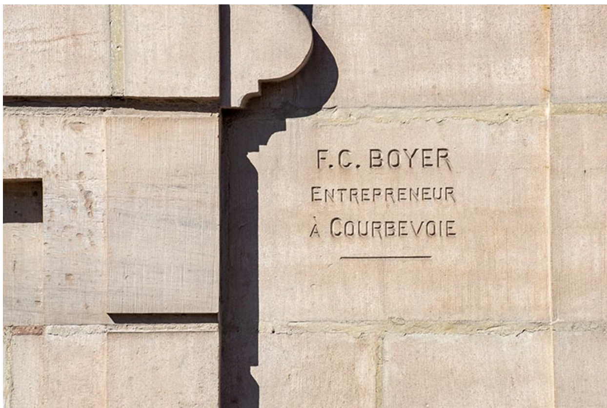
Façade sur la rue de Grammont, partie centrale, inscription : "F.C. BOYER / ENTREPRENEUR / À COURBEVOIE".
