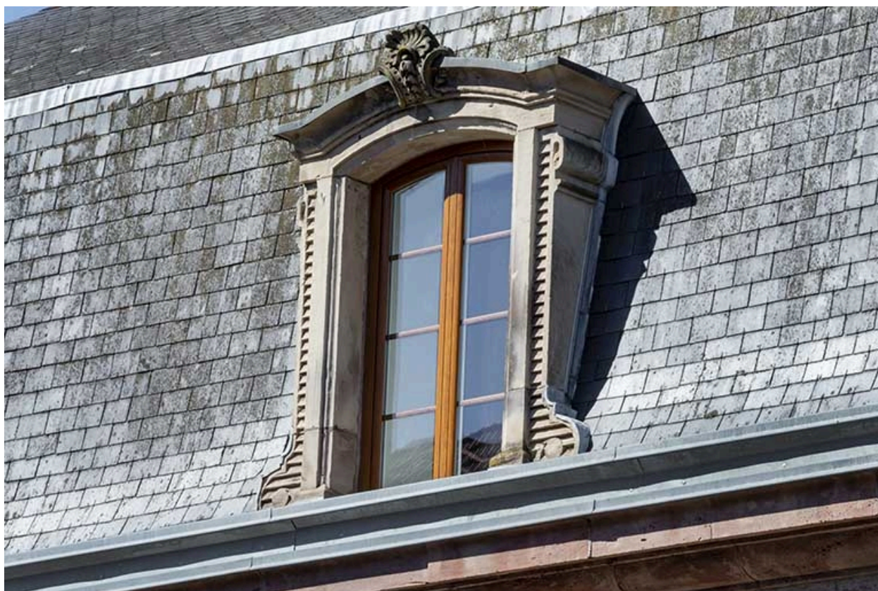
Maison Desgranges, lucarne est (lucarne centrale).
