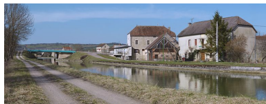
Arrivée en amont du pont : fermes sur la rive droite. Phot. Thierry Kuntz IVR26_20122102707NUC4A
