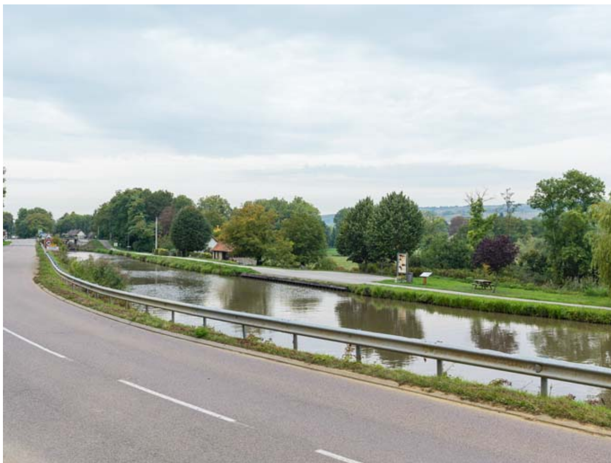
Vue du site, avec le pont en arrière-plan.
