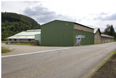
Extensions nord (entrepôts industriels). Phot. Jérôme Mongreville IVR43_20057000311NUCA
