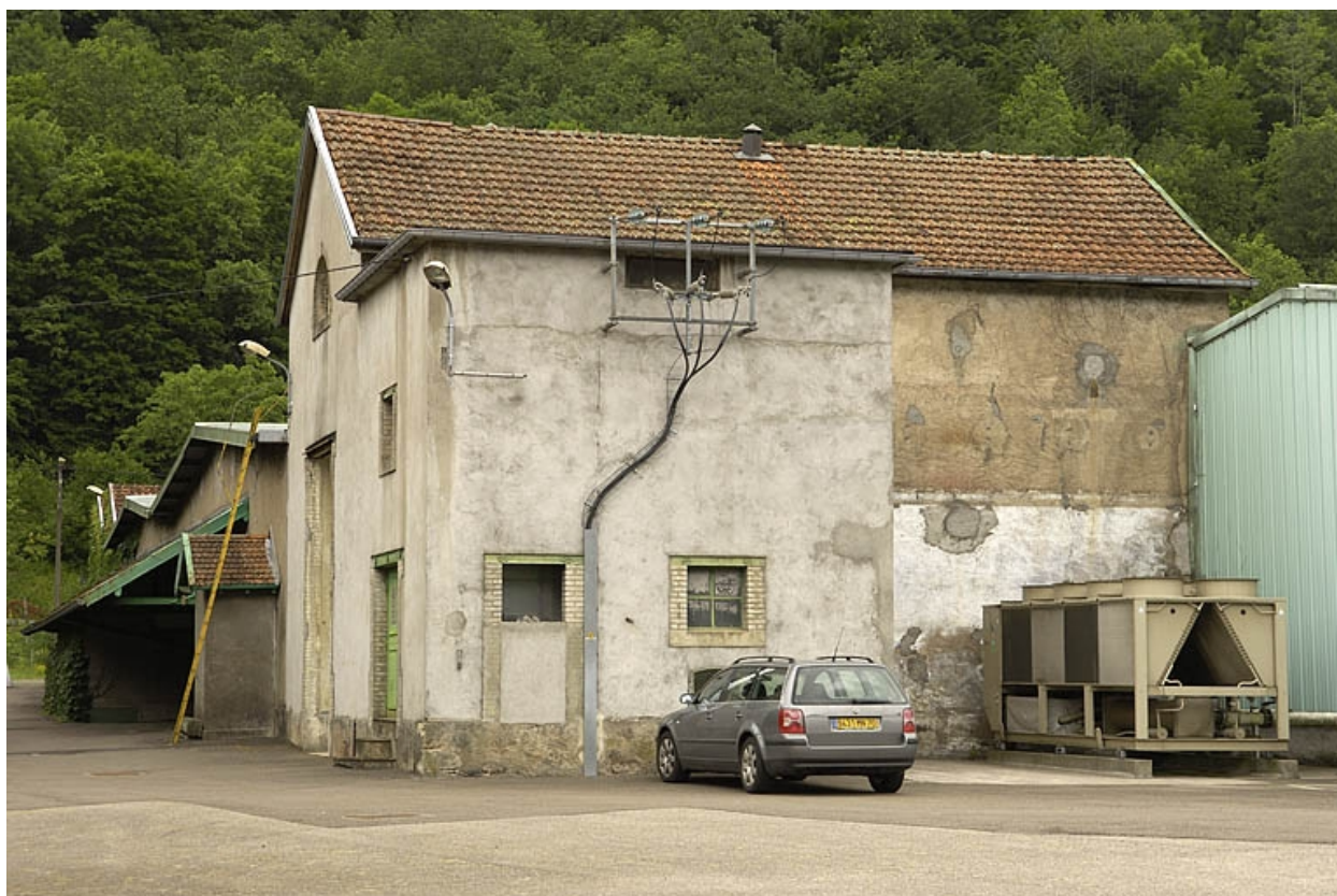
Transformateur et ancienne chaufferie.
