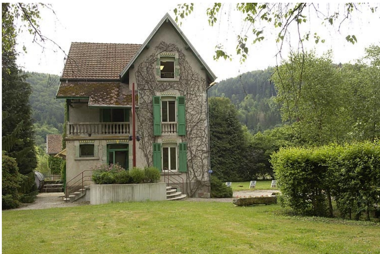
Ancien logement patronal. Façade ouest.
