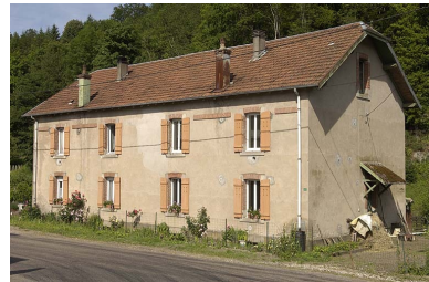
Logement ouvrier collectif. Phot. Jérôme Mongreville IVR43_20057000312NUCA
