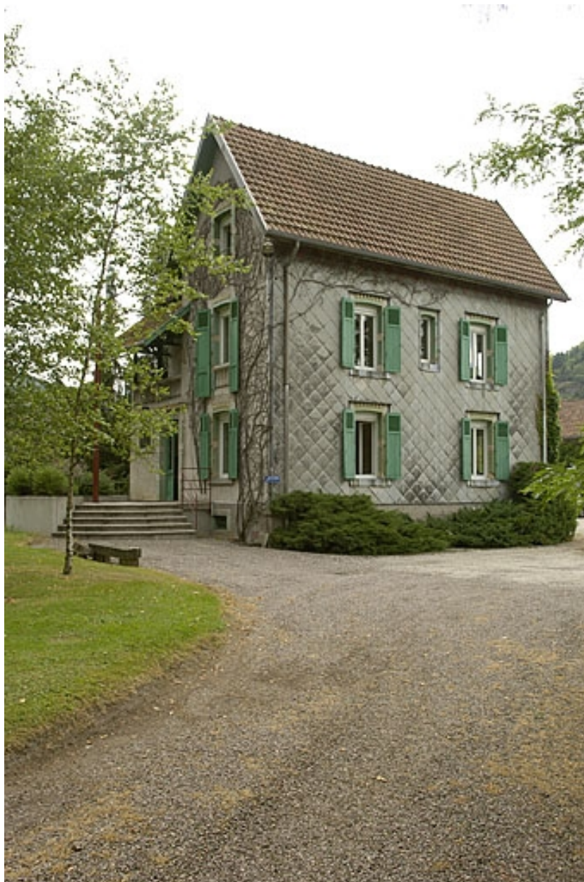
Ancien logement patronal. Vue depuis l'entrée.
