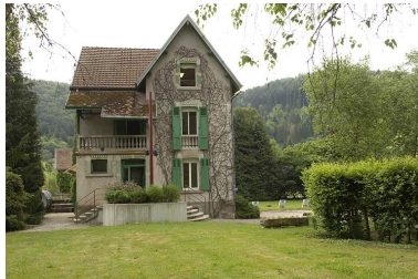
Ancien logement patronal. Façade ouest. Phot. Jérôme Mongreville IVR43_20057000318NUCA
