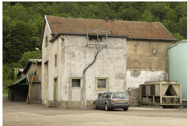
Transformateur et ancienne chaufferie. Phot. Jérôme Mongreville IVR43_20057000316NUCA
