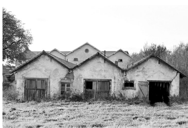
Murs-pignons de l'étable. Phot. Yves Sancey IVR43_20009000738X
