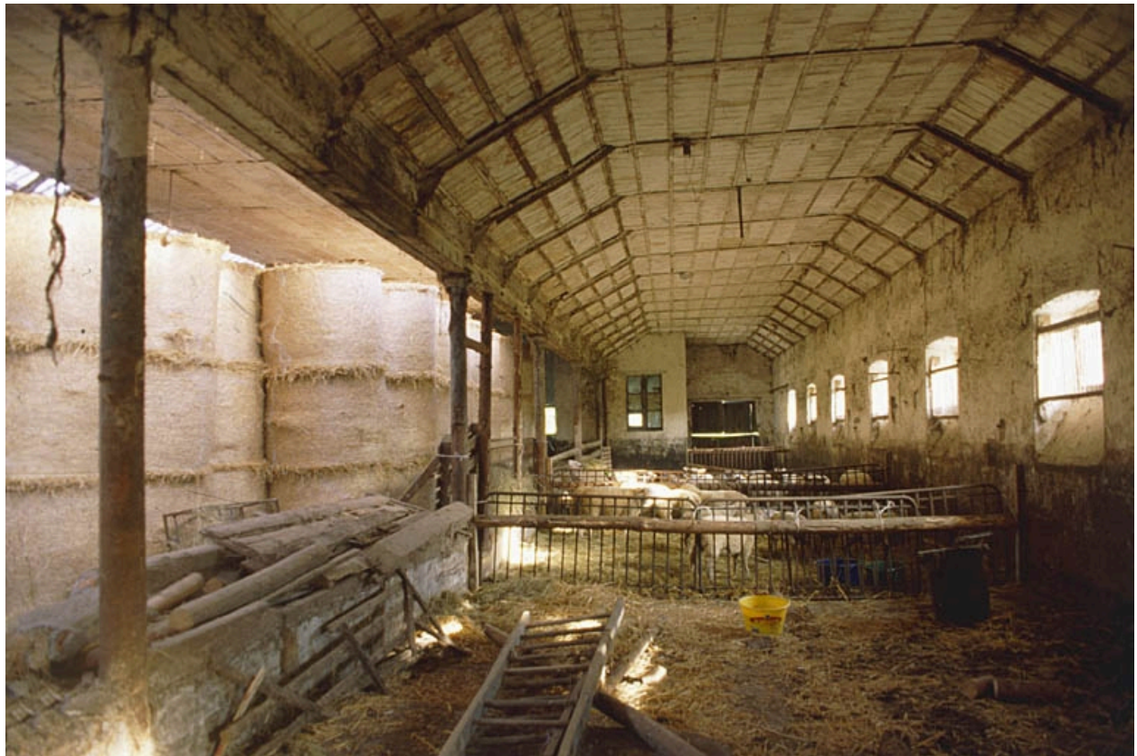
Travée sud de l'étable.
