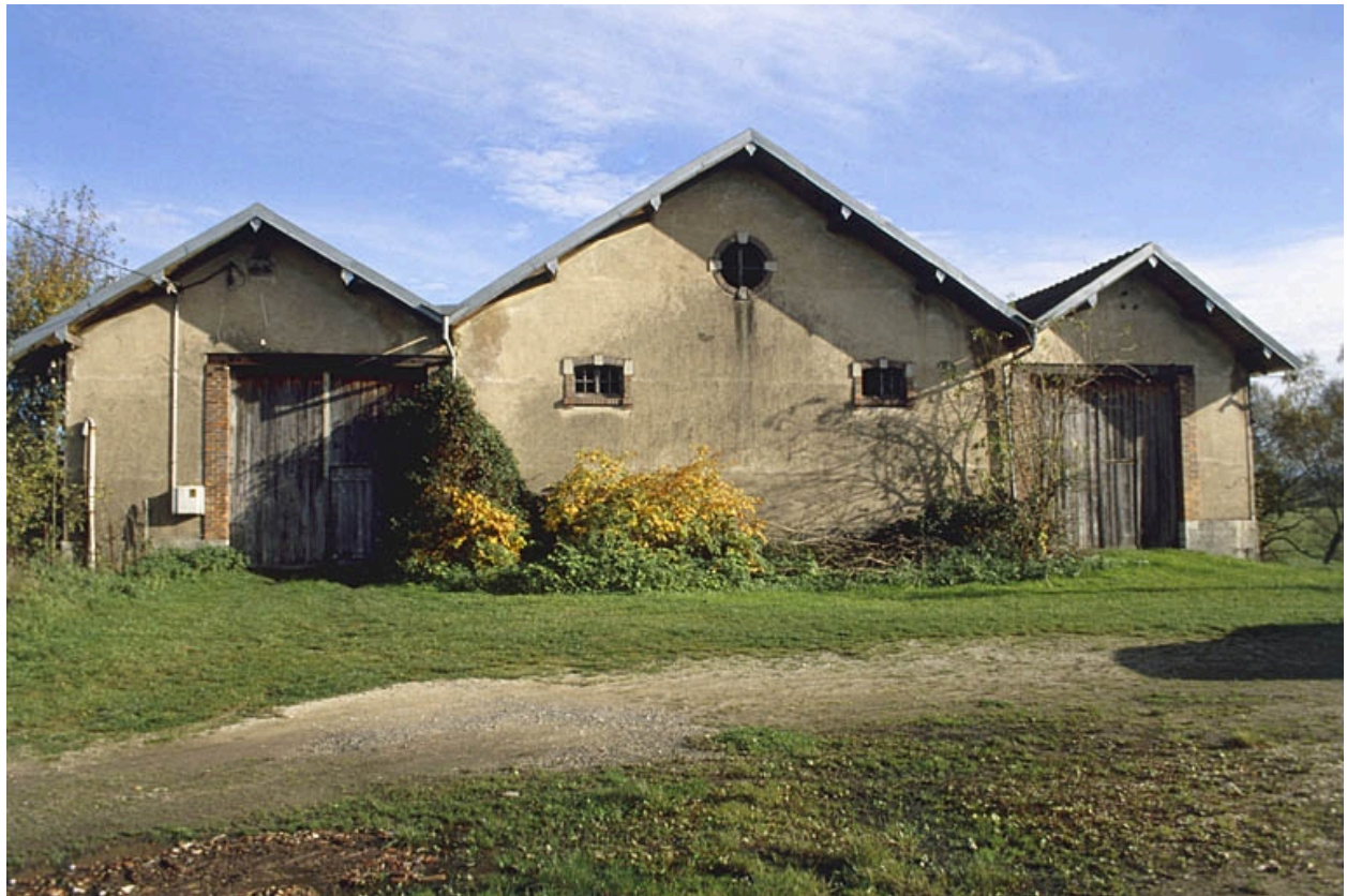
Murs-pignons du fenil.
