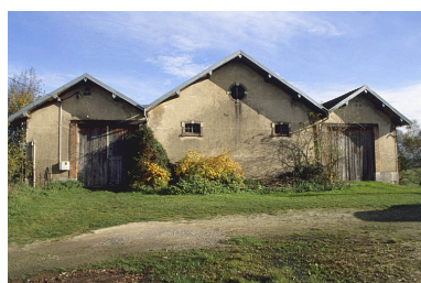
Murs-pignons du fenil. Phot. Yves Sancey IVR43_20009000731ZA
