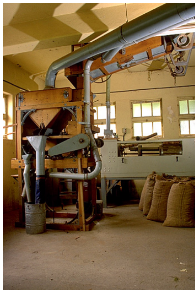
Vue d'ensemble. Phot. Jérôme Mongreville IVR43_19973900701ZA
