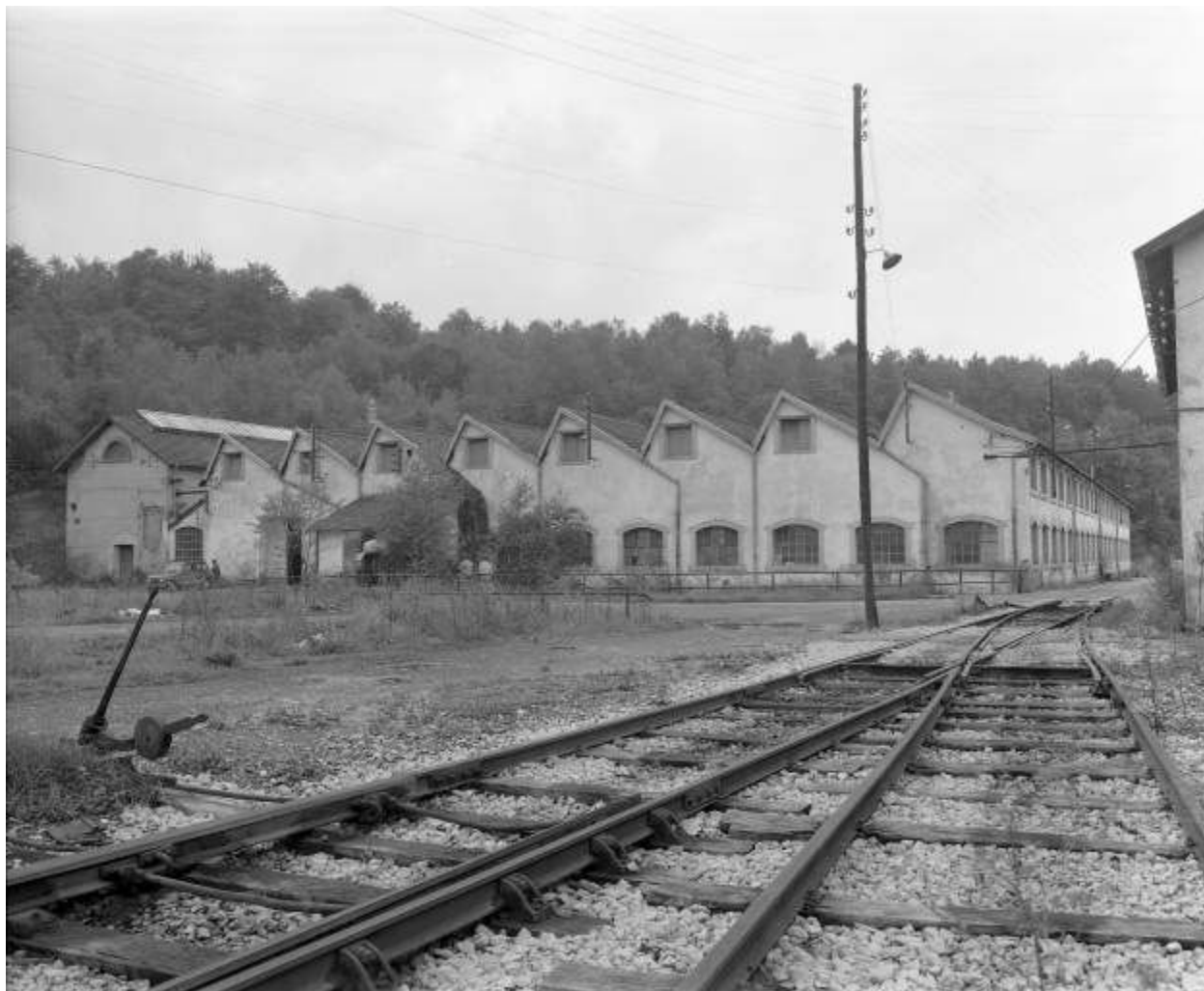
Atelier des pompes depuis l'est en 1981.
