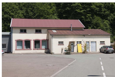
Atelier d'entretien. Phot. Jérôme Mongreville IVR43_20112501665NUC4A
