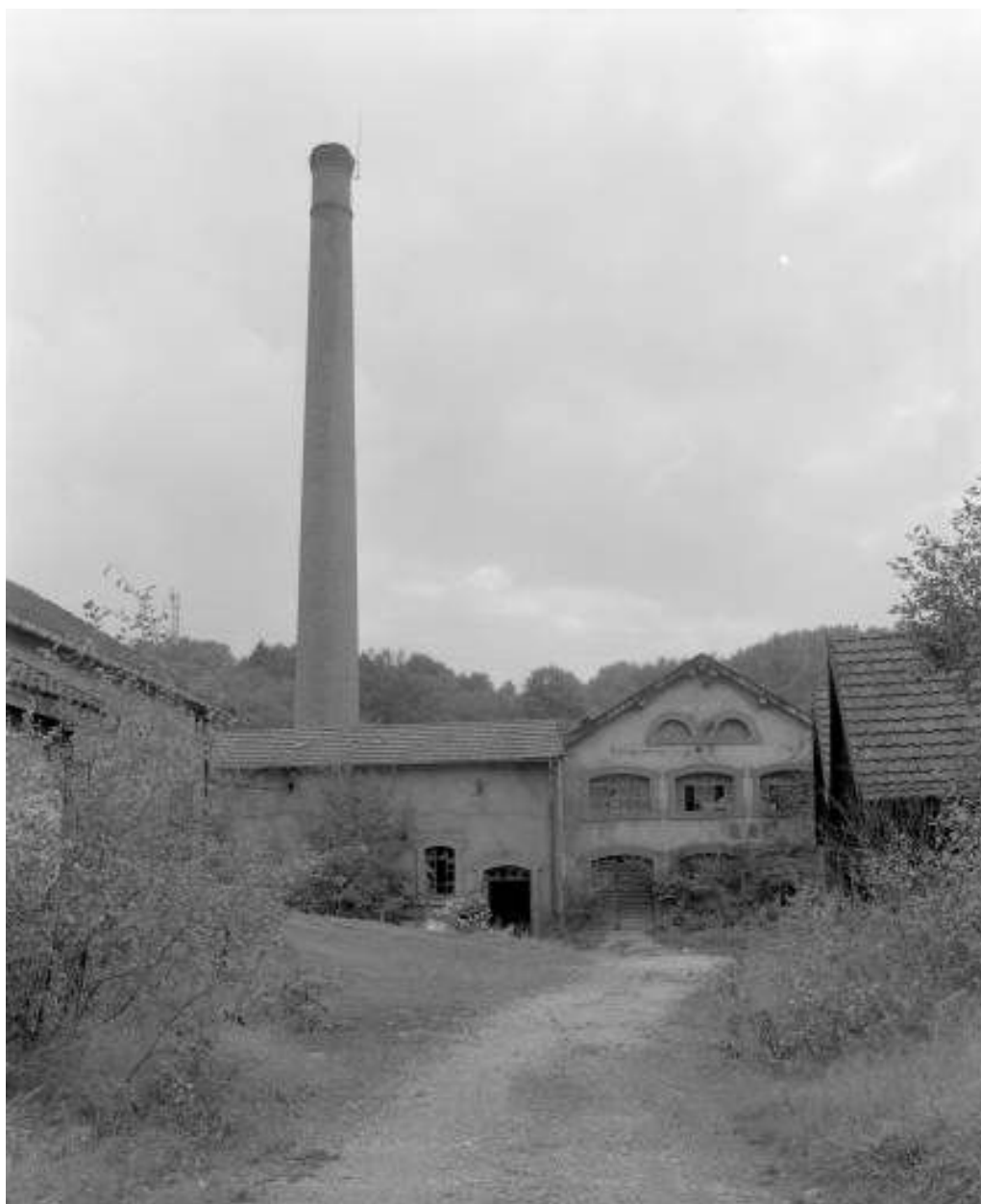
Façade nord de l'atelier de galvanisation en 1981.
