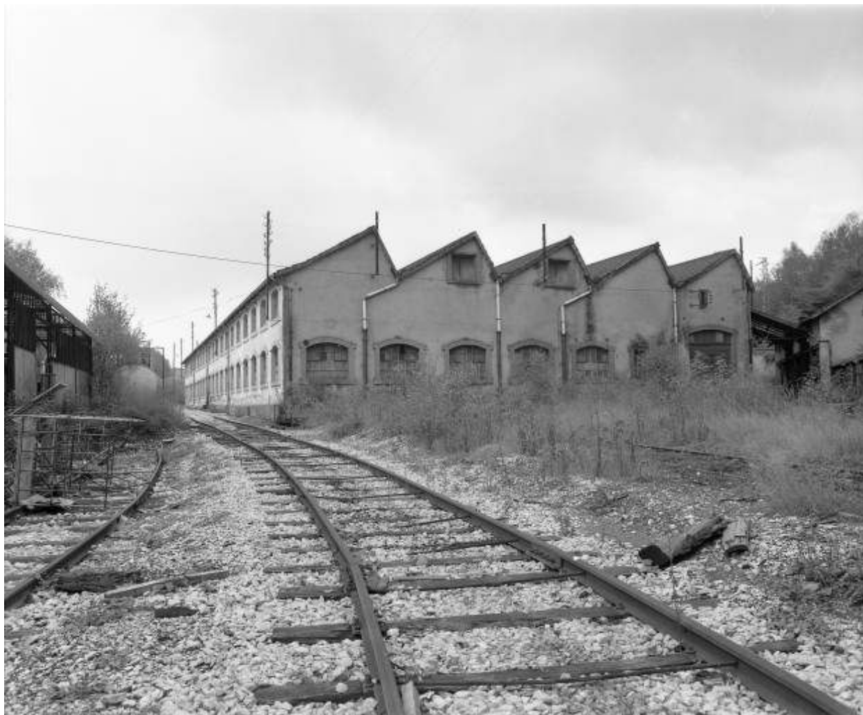
Atelier des pompes depuis l'ouest en 1981.
