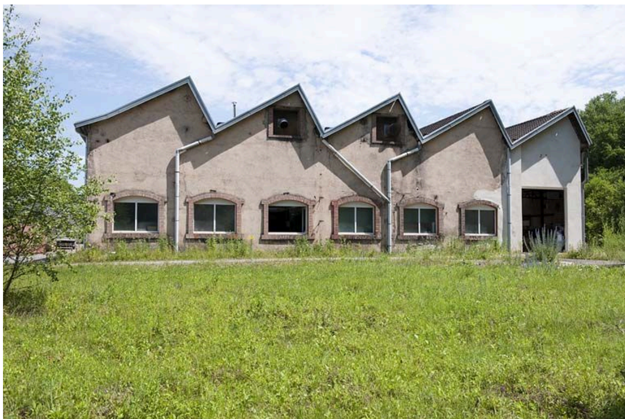
Atelier de fabrication des pompes. Mur-pignons ouest.
