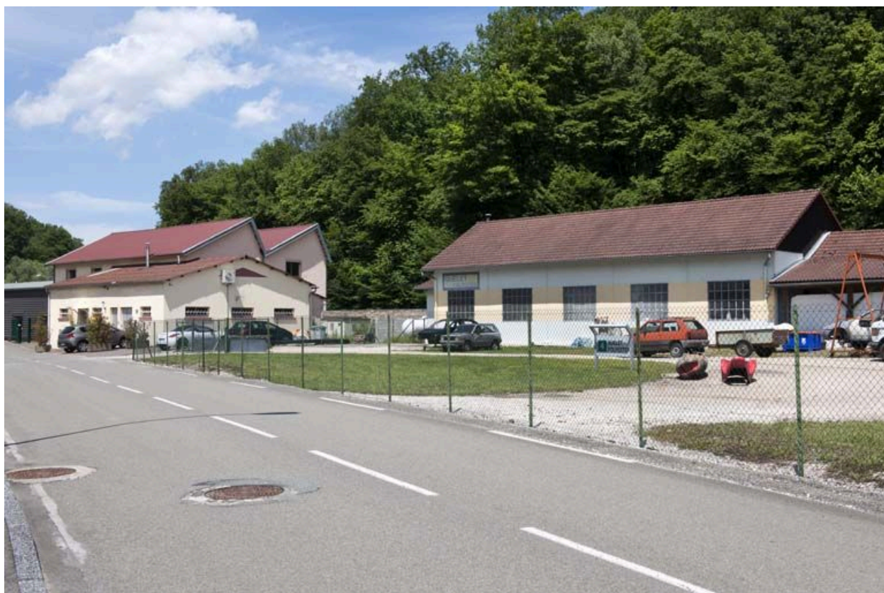
Vue rapprochée depuis le nord-ouest.
