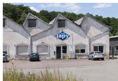
Atelier de fabrication des pompes. Travées nord. Phot. Jérôme Mongreville IVR43_20112501664NUC4A
