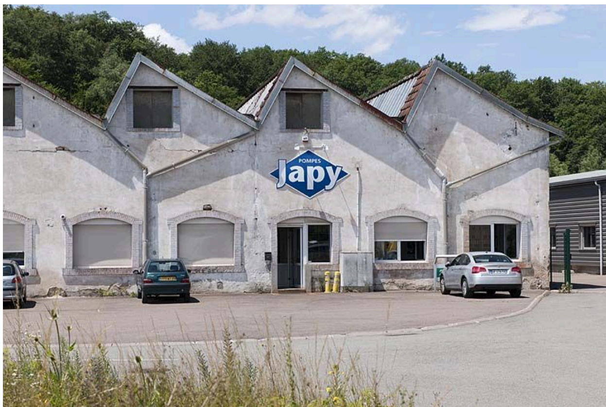
Atelier de fabrication des pompes. Travées nord.
