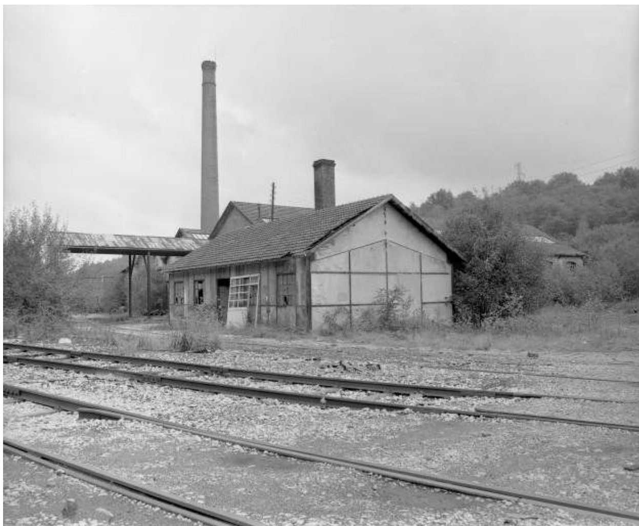
Chaufferie devant l'atelier de galvanisation en 1981.
