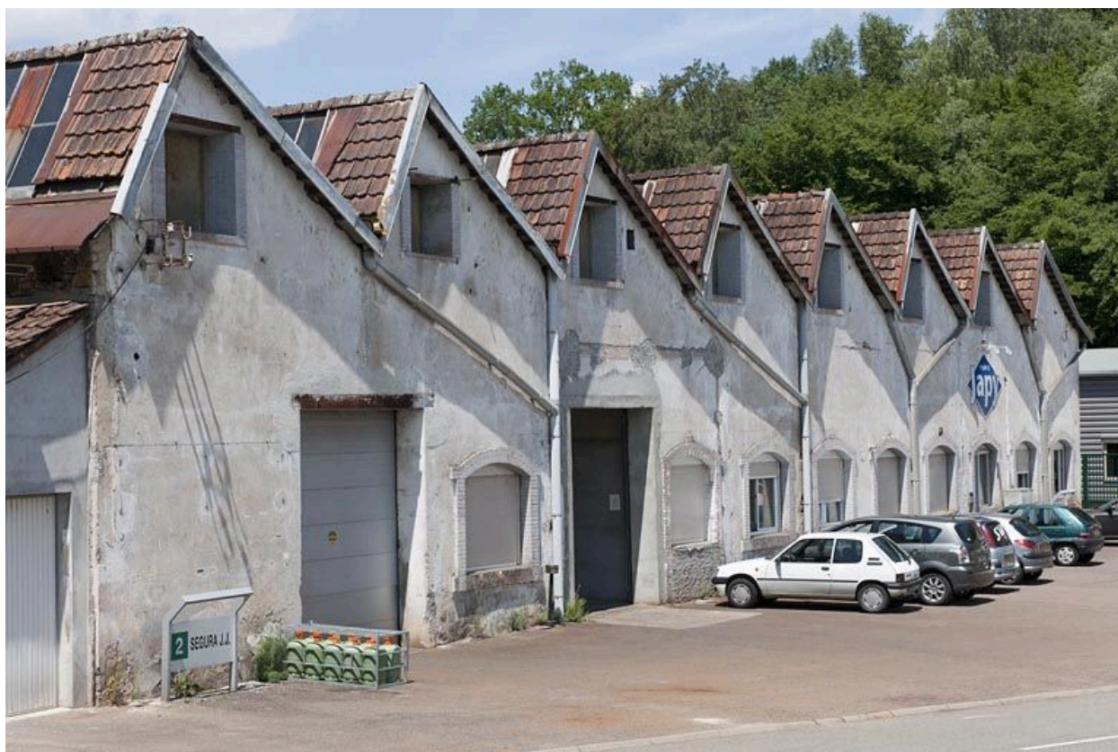
Atelier de fabrication des pompes. Sheds est.
