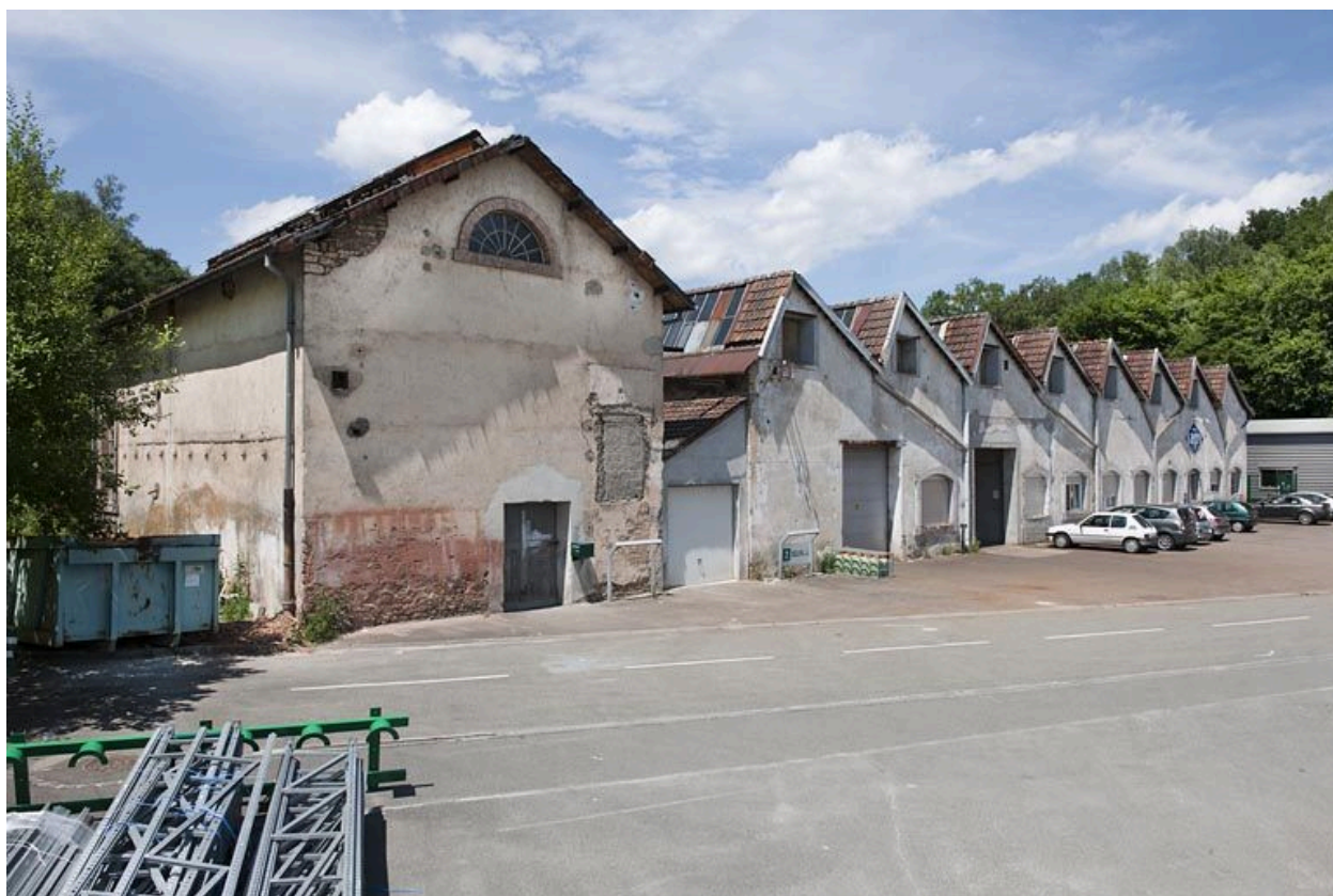
Atelier de fabrication des pompes. Mur-pignons est.
