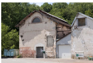
Ancienne chaufferie. Phot. Jérôme Mongreville IVR43_20112501180NUC4A
