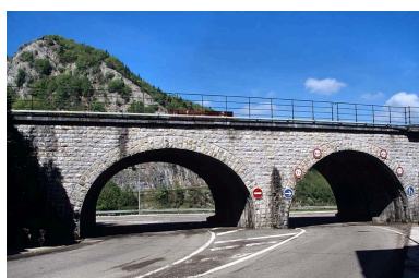
Elévation occidentale : arches enjambant la rue. Phot. Yves Sancey IVR43_20053900409ZA
