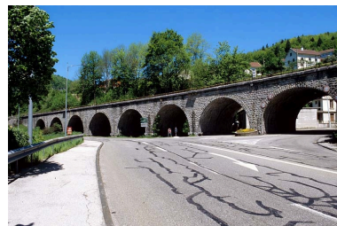
Elévation orientale, vue de trois quarts droite. Phot. Yves Sancey IVR43_20053900407ZA
