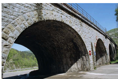
Elévation occidentale vue en enfilade, depuis le sud-est. Phot. Yves Sancey IVR43_20053900412ZA
