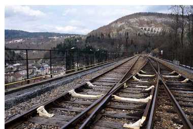
Vue d'ensemble du tablier, depuis la voie côté gare. Phot. Yves Sancey IVR43_20053900411ZA
