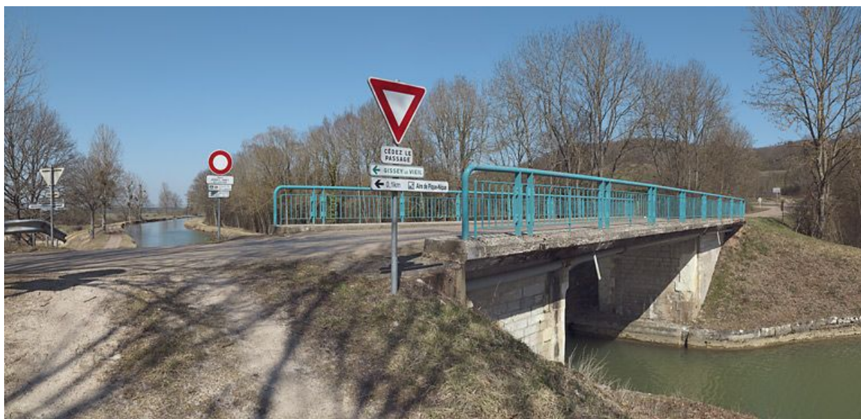
Vue d'ensemble du pont.
