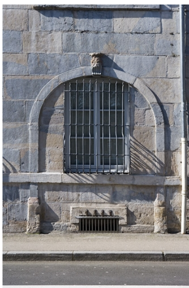
Détail d'une arcade boutiquière murée sur la façade latérale gauche. Phot. Yves Sancey IVR43_20072500223NUCA
