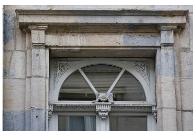
Détail du décor du tympan de la porte-fenêtre donnant sur le balcon. Phot. Yves Sancey IVR43_20072500232NUCA
