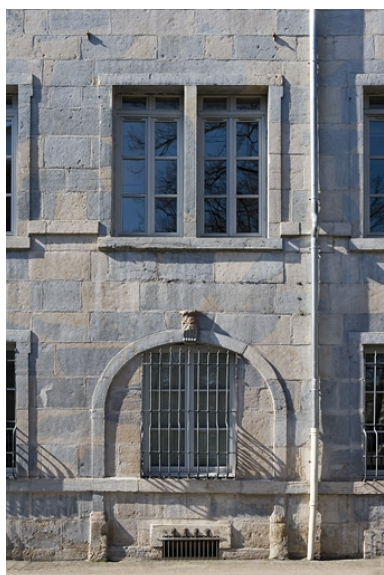
Détail de quelques baies sur la façade latérale gauche. Phot. Yves Sancey IVR43_20072500224NUCA
