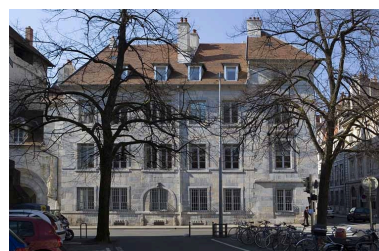
Vue d'ensemble de la façade latérale gauche depuis la promenade Granvelle. Phot. Yves Sancey IVR43_20072500222NUCA
