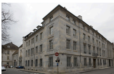
Vue d'angle de l'immeuble. Phot. Yves Sancey IVR43_20072500230NUCA
