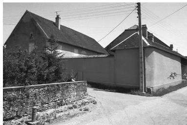
Vue d'ensemble. Phot. Bernard Lardière IVR43_19817000124Z
