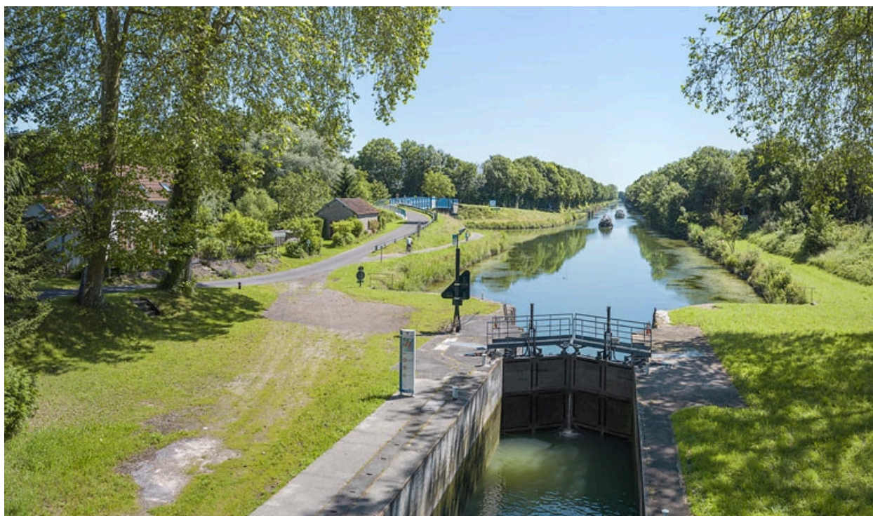
La dérivation d'Heuilley-sur-Saône vue depuis le site d'écluse 18 (21).
