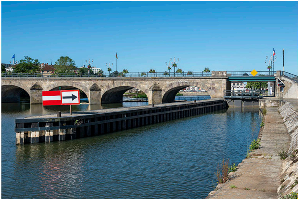
Vue amont de l'arche marinière à Gray.
