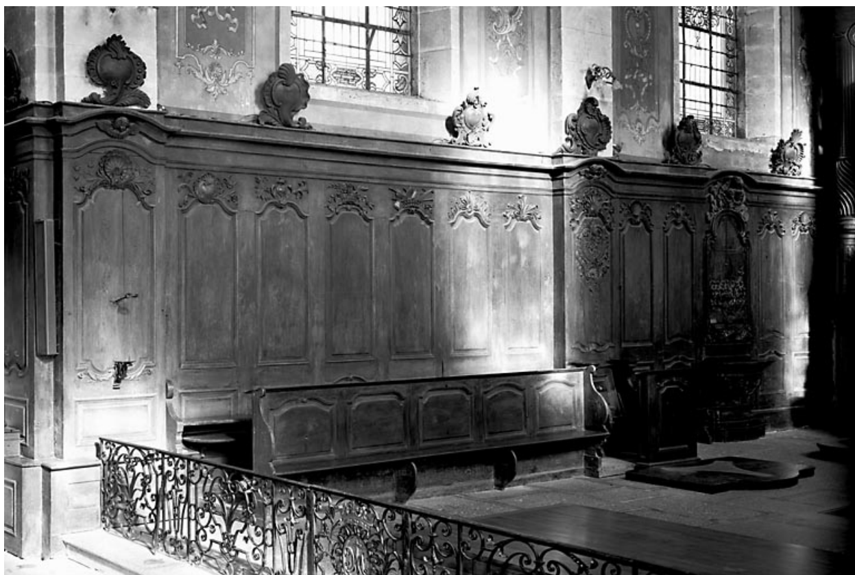
Vue d'ensemble du côté gauche du chœur.
