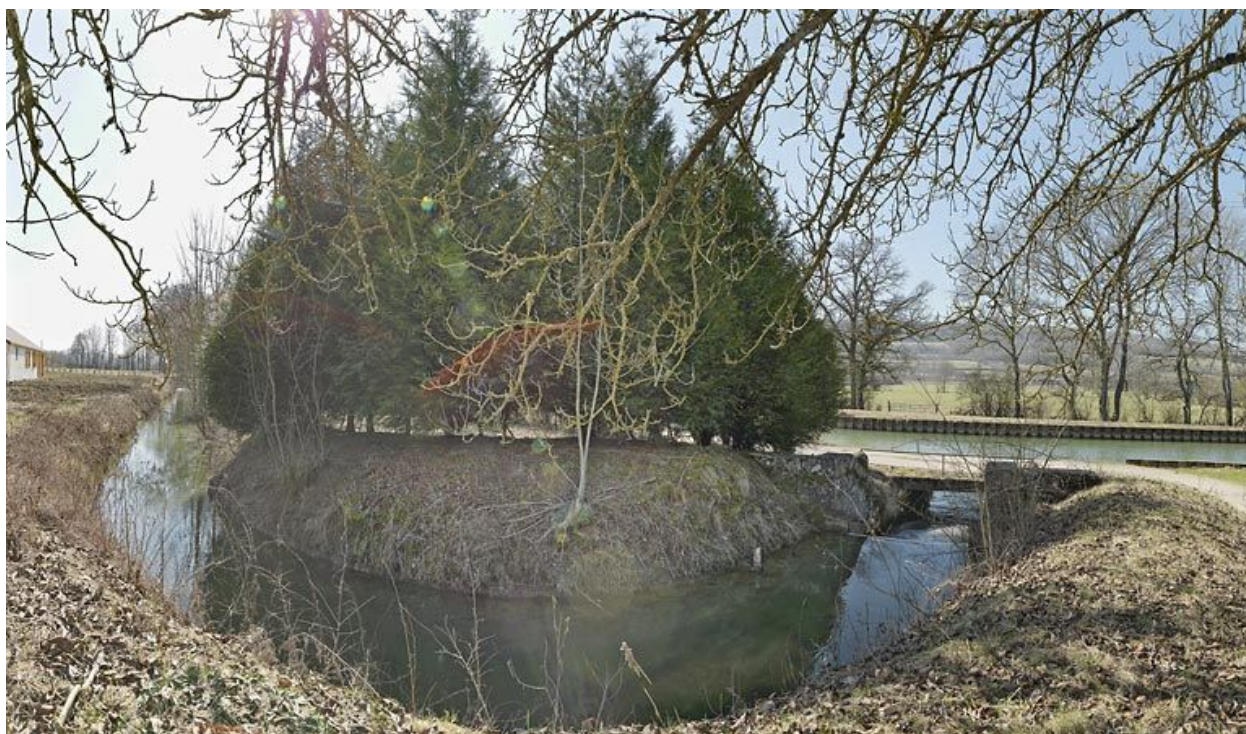
Arrivée au canal de la rigole d'alimentation.
