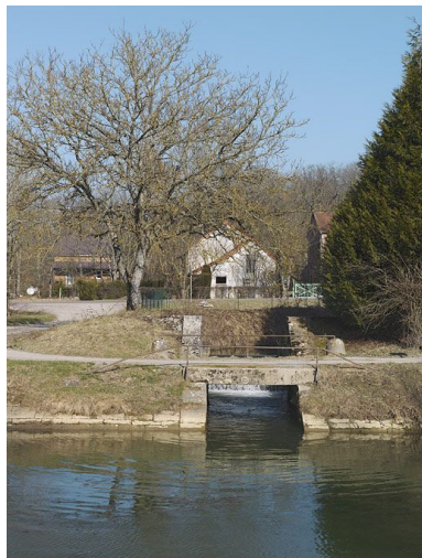
Entrée de la rigole d'alimentation dans le canal. Phot. Thierry Kuntz IVR26_20122102659NUC4A
