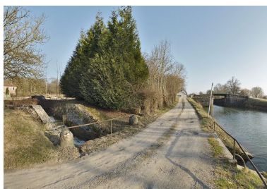
Passage de la rigole d'alimentation sous le chemin de halage et sous le canal. Phot. Thierry Kuntz IVR26_20122102658NUC4A
