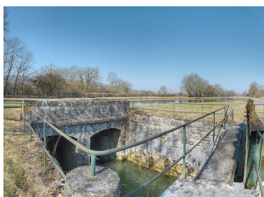
Arrivée de la Brionne vers le canal : vannes et aqueduc à deux arches. Phot. Thierry Kuntz IVR26_20122102609NUC4A
