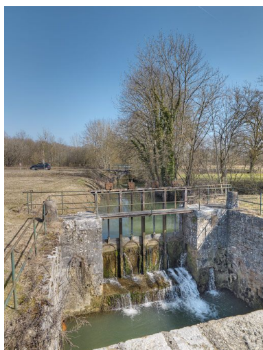
Arrivée de la Brionne vers le canal : les vannes prises de l'aqueduc. Phot. Thierry Kuntz IVR26_20122102610NUC4A
