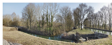
Arrivée de la Brionne vers le canal. Une partie de l'eau passe sous le canal, une autre partie vient alimenter un contre-fossé le long du canal. Phot. Thierry Kuntz IVR26_20122102603NUC4AQ
