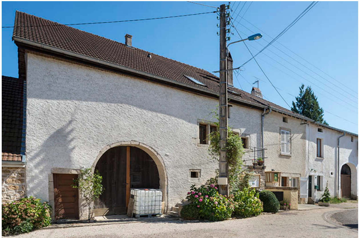
La porte charretière, façade antérieure.
