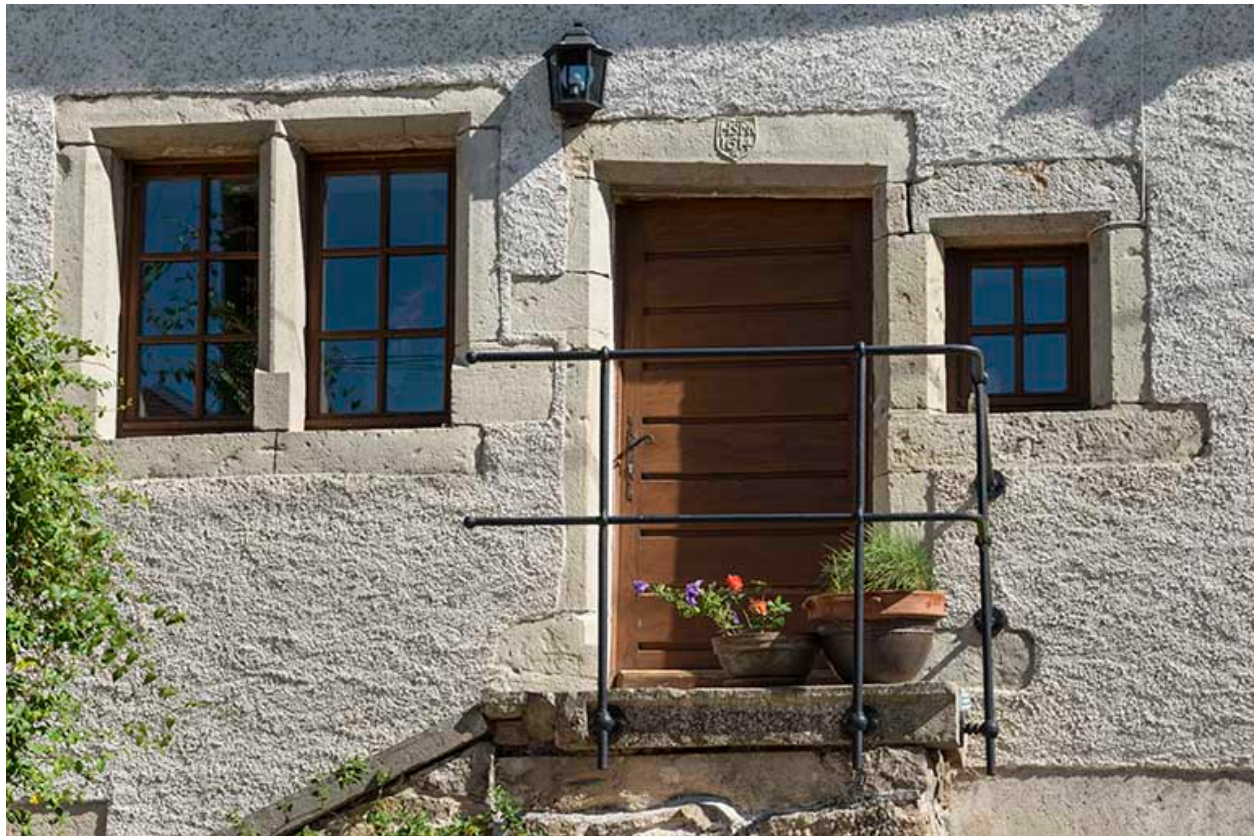
Les ouvertures au niveau de l'étage carré.
