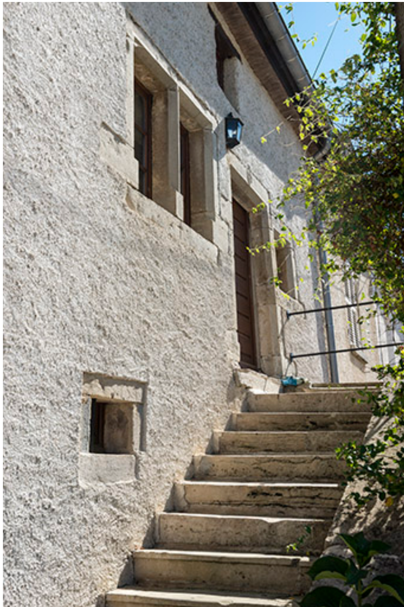
L'escalier extérieur permettant d'accéder à l'étage carré.
