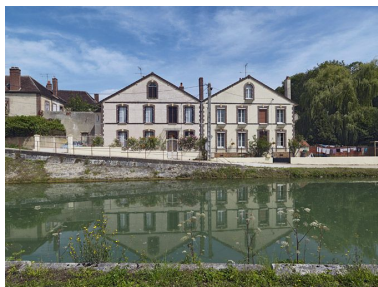
Amont du pont, rive droite : d'anciennes usines. Phot. Thierry Kuntz IVR26_20118900213NUC4A
