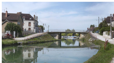
Vue d'ensemble prise d'aval. Phot. Thierry Kuntz IVR26_20118900212NUC4A
