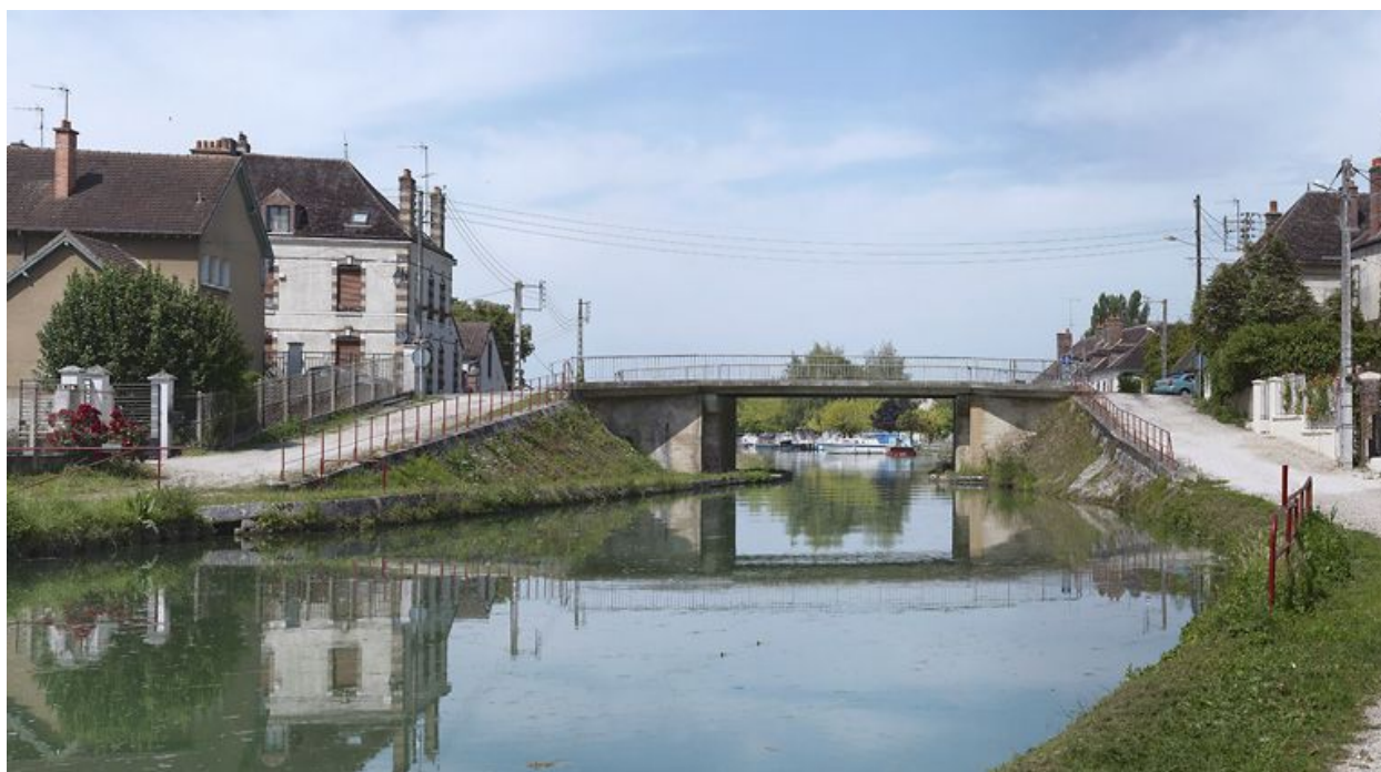
Vue d'ensemble prise d'aval.
