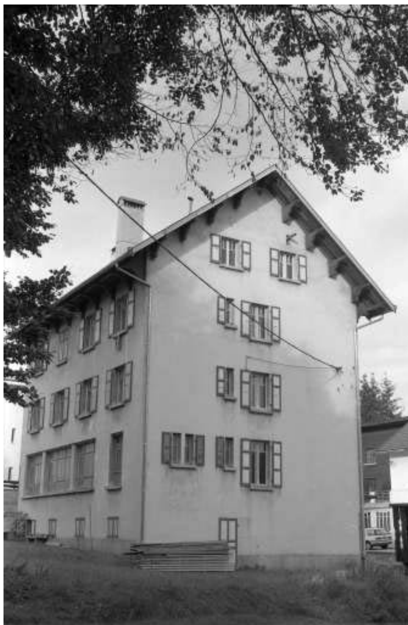
Façades antérieure et latérale droite.
