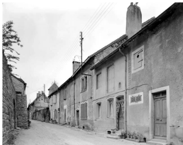
Vue générale de la rue Haute du Bourg. Phot. Yves Sancey IVR43_19793900275V
