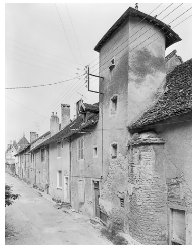
Vue générale de la rue Haute du Bourg. Phot. Yves Sancey IVR43_19793900272V
