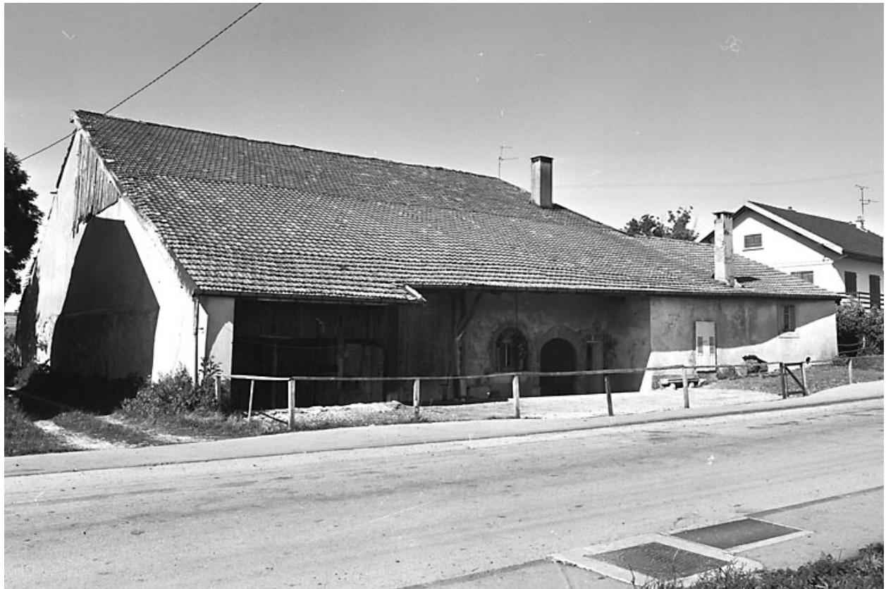
Gouttereau sur rue.
