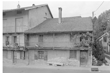
Façade antérieure. Phot. Jérôme Mongreville IVR43_19963901009X
