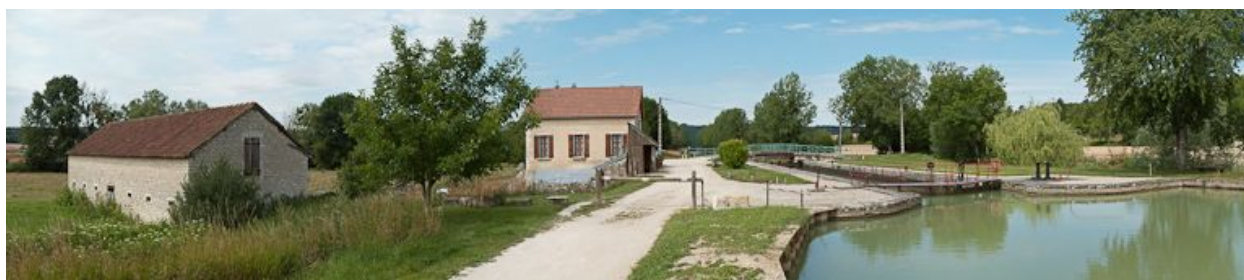
Vue d'ensemble du site d'écluse.
