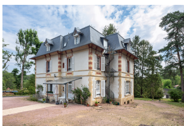
Vue d'ensemble depuis le sud. Phot. Pierre-Marie Barbe-Richaud IVR26_20195800426NUC4A
