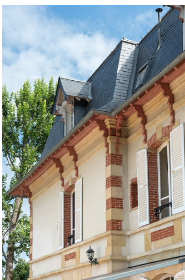
Détail de l'avant-corps de la façade postérieure, baies de l'étage carré et toiture à égout retroussé. Phot. Pierre-Marie Barbe-Richaud IVR26_20195800427NUC4A
