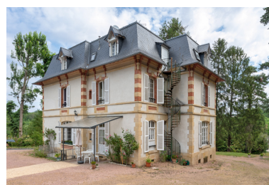
Vue d'ensemble depuis le sud. Phot. Pierre-Marie Barbe-Richaud IVR26_20195800425NUC4A
