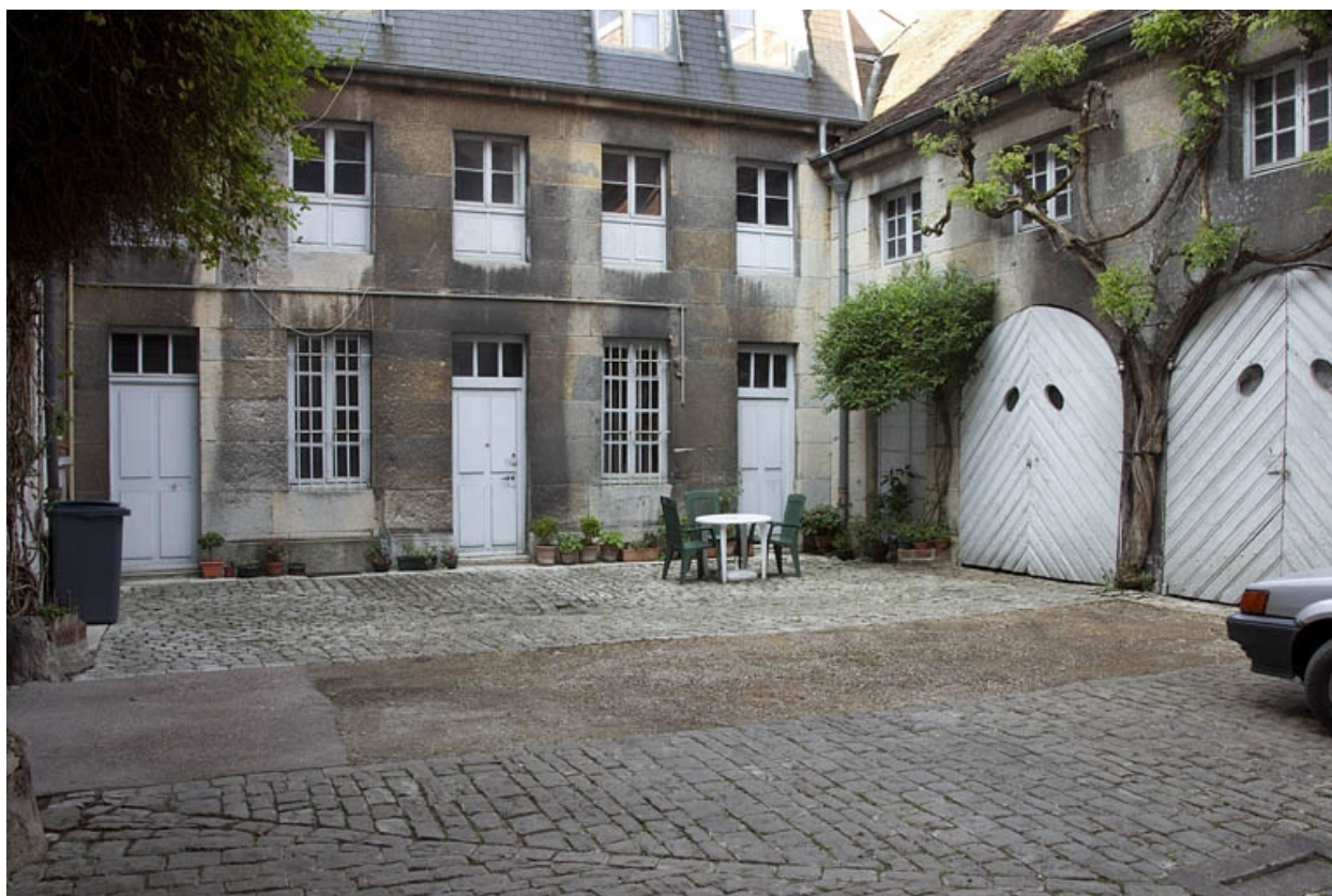
Vue de l'aile gauche des communs.
