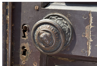
Portail d'entrée : détail de la poignée.
