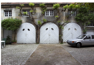
Vue des remises et écuries de face. Phot. Yves Sancey IVR43_20112500771NUC2A
