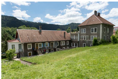
Vue d'ensemble, depuis le nord (extension à gauche, atelier et maison à droite). Phot. Sonia Dourlot IVR43_20162501725NUC4A
