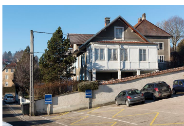
Extension : façade latérale droite. Phot. Sonia Dourlot
