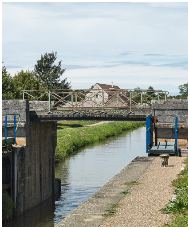
Vue du pont. Phot. Pierre-Marie Barbe-Richaud IVR26_20175800348NUC2A
