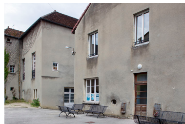
Vue des façades sur cour . Phot. Sonia Dourlot IVR43_20143900737NUC2A
