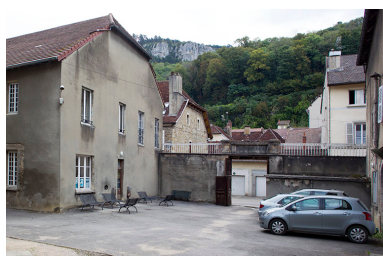
Cour intérieure, site Bonotte. Phot. Sonia Dourlot IVR43_20143900738NUC2A
