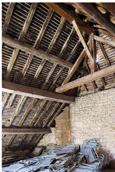
Maison Bonotte : détail de la charpente. Phot. Sonia Dourlot IVR43_20143900741NUC2A
